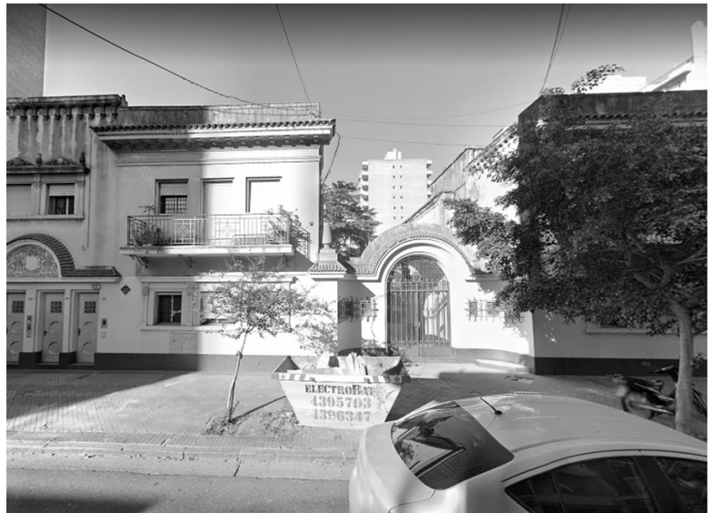
Conjunto de viviendas calle Ov. Lago y Santa Fe, Rosario. Acceso por pasillo común.
