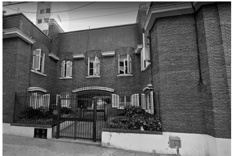
Conjunto de viviendas calle Tucumán 1048, Rosario. Acceso por pasillo común.
