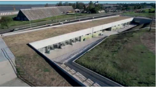
Aulario Nuevo Edificio. C.U.R (2021)
