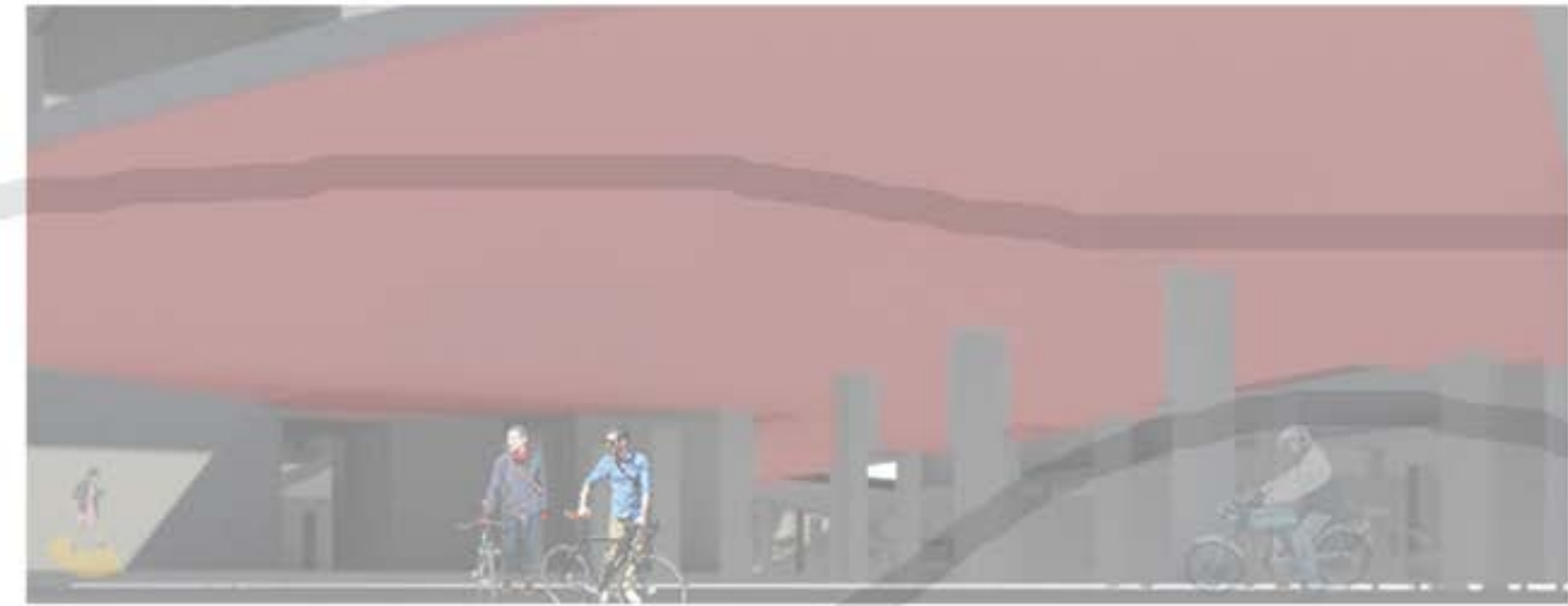
El abajo de un puente principal | año 2015
