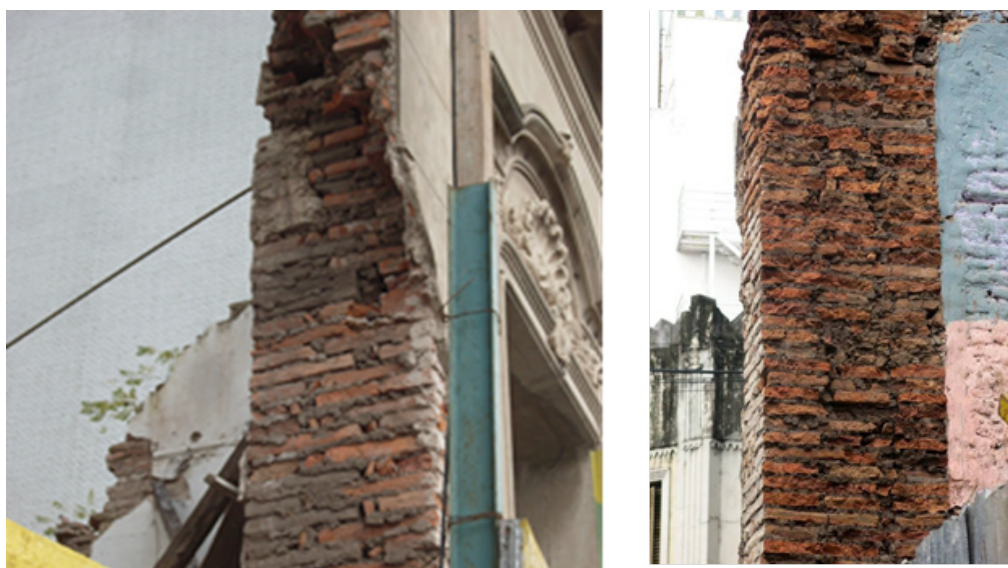
Figura 3. Fachadas de ladrillos asentados en barro a) Córdoba 600, b) Buenos Aires 990
