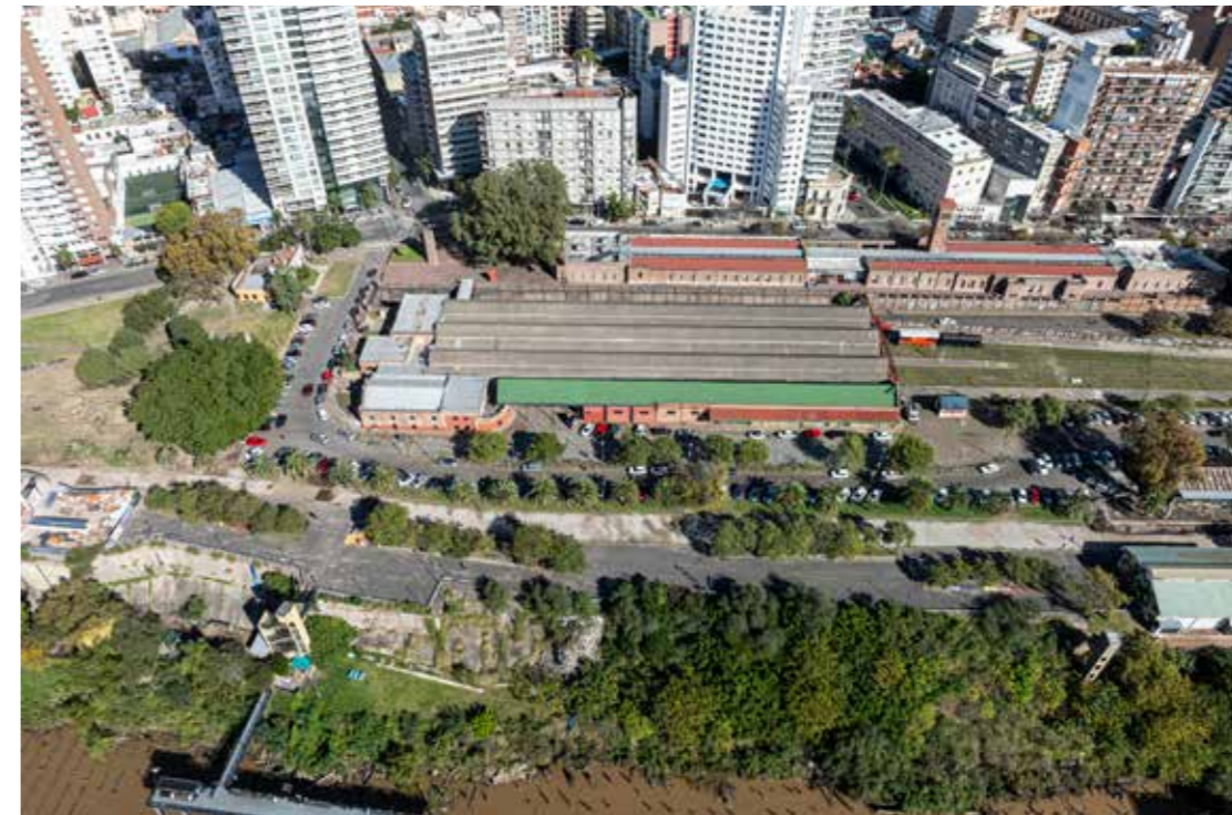
Arriba: fotografía aérea de la obra en 1998, antes de la intervención. Autor: Walter Salcedo. | Abajo: fotografía aérea del estado actual de la obra (2025). Autor: Walter Salcedo.
