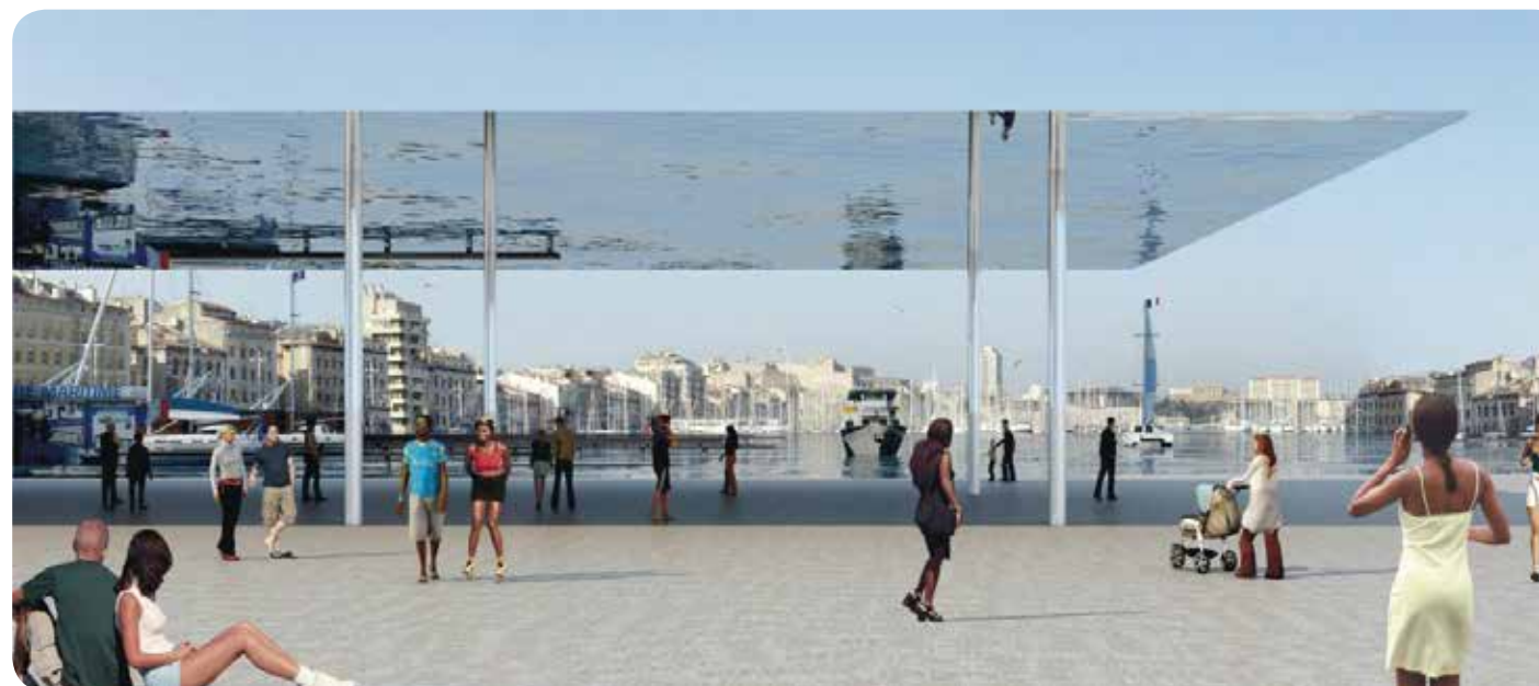
Proyecto Ganador del Premio Europeo del espacio público urbano 2014: Plan Maestro para el Viejo Puerto de Marsella / Foster + Partners
