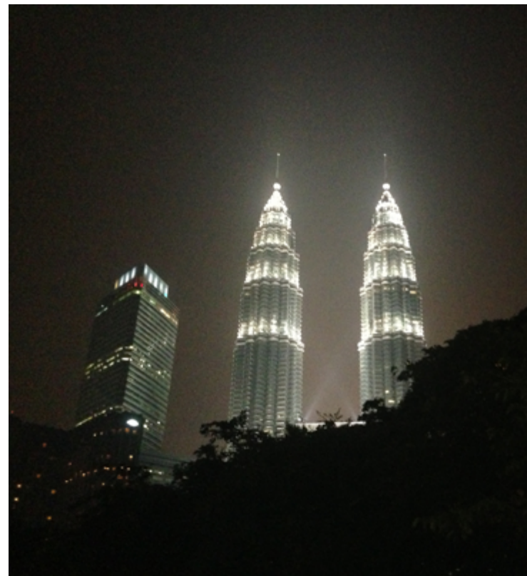
Cesar Pelli. Torres Petronas (1998), Kuala Lumpur. Foto: A. Ferlenga.
