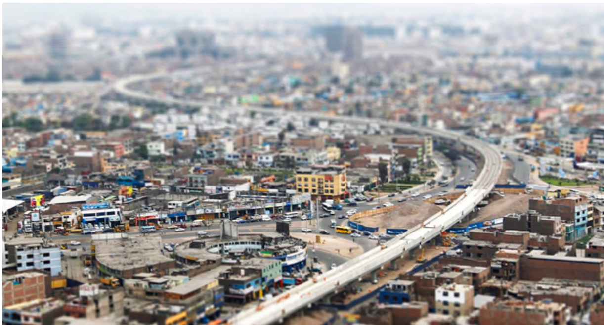
Viaducto de la metropolitana, Lima. Foto: A. Bonadio.
