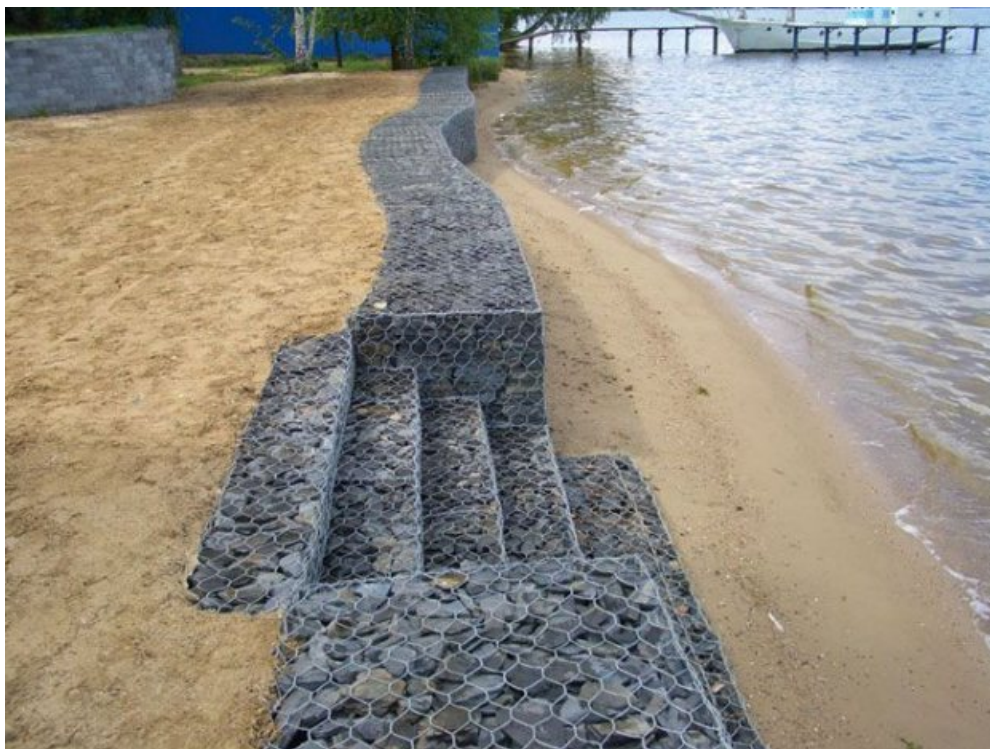
Figura 4.4.1. Gaviones utilizados como escaleras.
