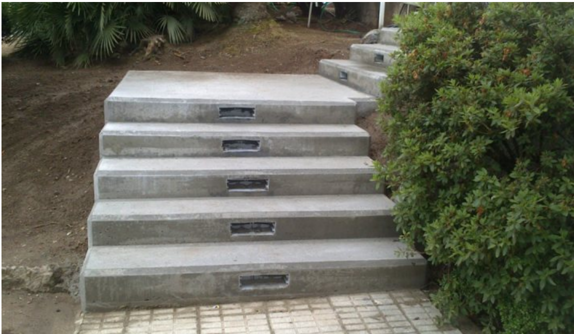
Figura 5.1.2 - Escaleras de hormigón. Fuente: Página Habitissimo.
