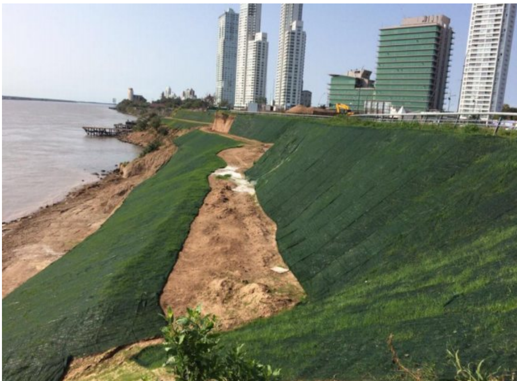
Figura 4.4.3. Barranca revestida con geomantas de refuerzo de vegetación; Fuente: coripa.com.ar
