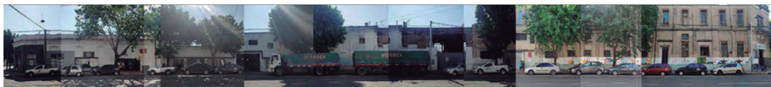
FACHADA OV. LAGOS
