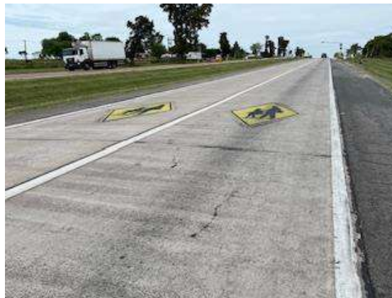
Figs.43 y 44: Señales Preformadas de Escuela en el Pavimento de Hormigón acompañadas con Señalización Vertical.
