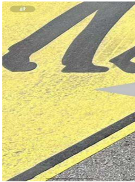
Fig. 17 y 18: observación de la superficie con Demarcación Tipo Imagen Preformada.
