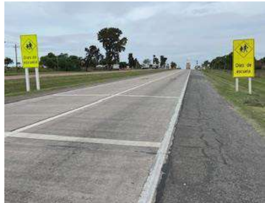
Figs.43 y 44: Señales Preformadas de Escuela en el Pavimento de Hormigón acompañadas con Señalización Vertical.
