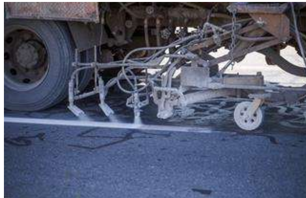
Fig.28: Ejemplo de Pintura Tipo Spray para pintado de líneas de demarcación: Delante va cayendo la pintura, detrás a la izquierda las pistolas van colocando Microesferas de Sembrado (en las Pistolas se regular su ángulo y la presión con que salen las Microesferas). No se disponía en ese momento de Imágenes del Pintado de Demarcación Tipo Imágenes con Material Termoplástico por Extrusión que fue la que se investigó: el procedimiento es el mismo que el mostrado en la Imagen 27: cae pintura por gravedad y atrás van las pistolas depositando las Microesferas de Sembrado. La única diferencia es que no es un camión que va avanzando sino un carro de pintado.
