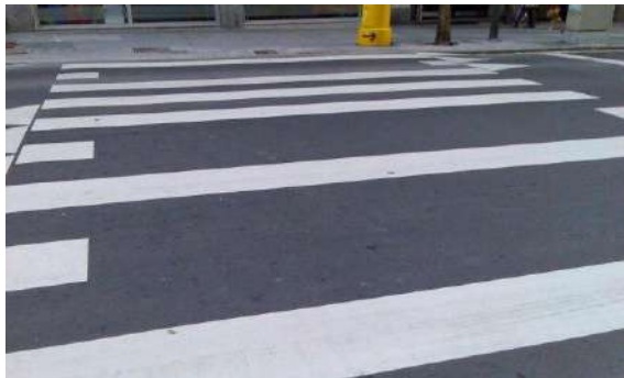
Figuras 35 y 36.- Marcas de Paso para Motociclistas (Fuente: Señalización Horizontal David Calavia Redondo – AETEC S.A España).
