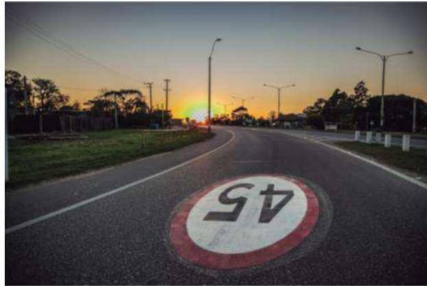
Fig.19: Preformado sobre la ruta.
