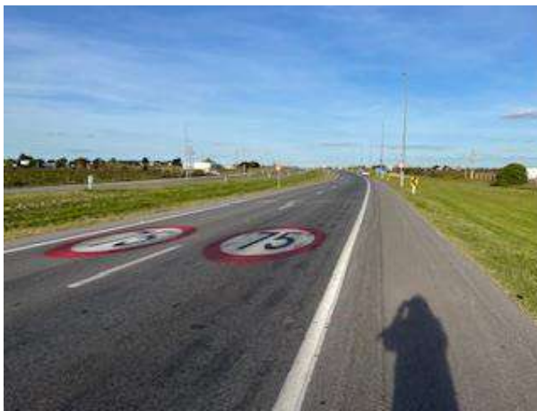
Fig.32 y 33: Demarcación Horizontal Tipo Imagen con Material Preformado en ruta 1. Zona de Velocidad 75 km/h en ruta de 90 km/h como velocidad de circulación.
