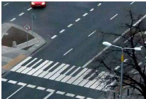
Figura 37.- Marcas de Paso para peatones (Fuente: Señalización Horizontal David Calavia Redondo – AETEC S.A España).
