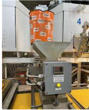
Fig.22: En el tanque superior naranja se encuentran las Microesferas de Sembrado, colocadas por la tolva a velocidad constante y de forma homogénea.
