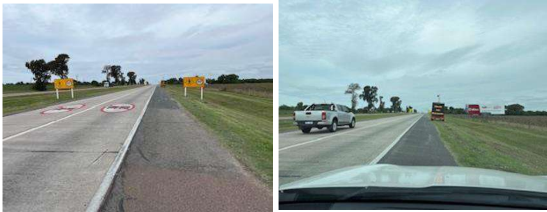
Fig.41 y 42: Señales Preformadas acompañando la Señalización Vertical de 60 en ruta 1. Cartel lumínico posterior de Circulación con Precaución.
