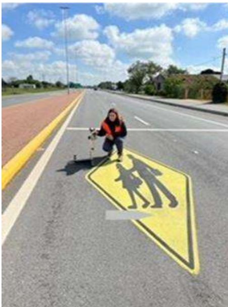
Fig. 17 y 18: observación de la superficie con Demarcación Tipo Imagen Preformada.
