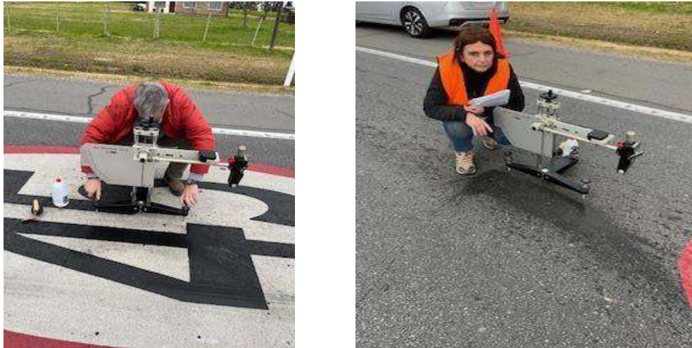
Figura 15: Ejemplo de Medición de Fricción sobre Señalización y Pavimento
