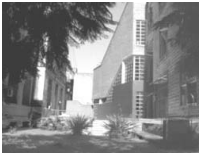
Parte de las instalaciones edilicias de la actual Facultad de Ciencias Bioquímicas y Farmacéuticas, UNR, mayo 2002.
