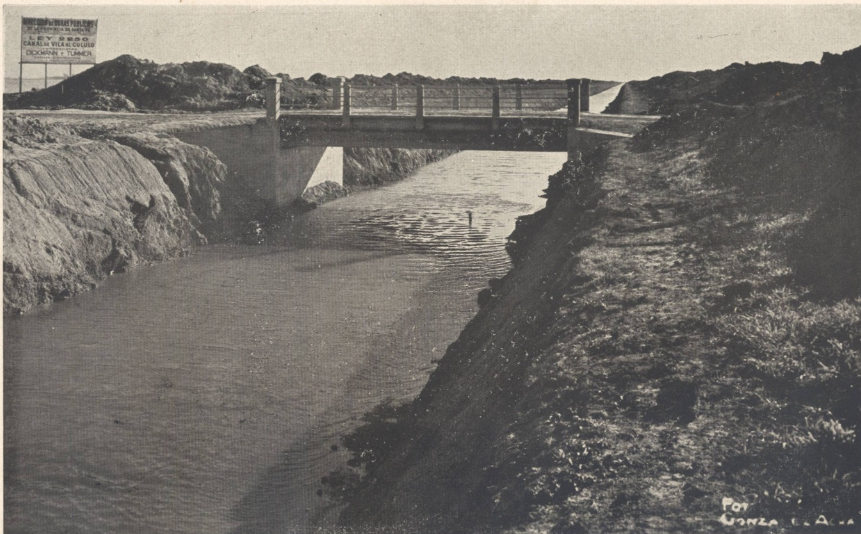
Canal de Vila al Cululú — Puentes tipo de hormigón armado sobre el curso del canal
