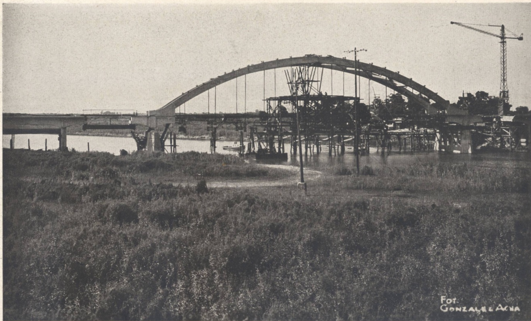
Arco de hormigón armado, de 80 metros de luz, sobre el cauce principal del Río Salado. Camino Santa Fe-Rosario
