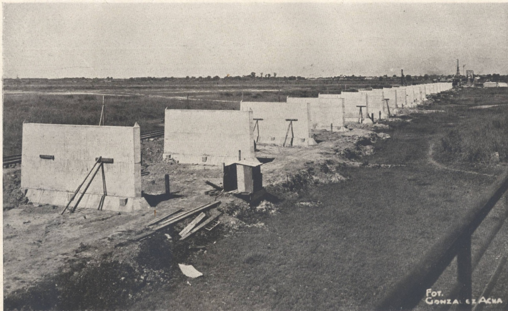
Pilares para vigas Gerber, de hormigón armado, en el puente sobre el Río Salado,
