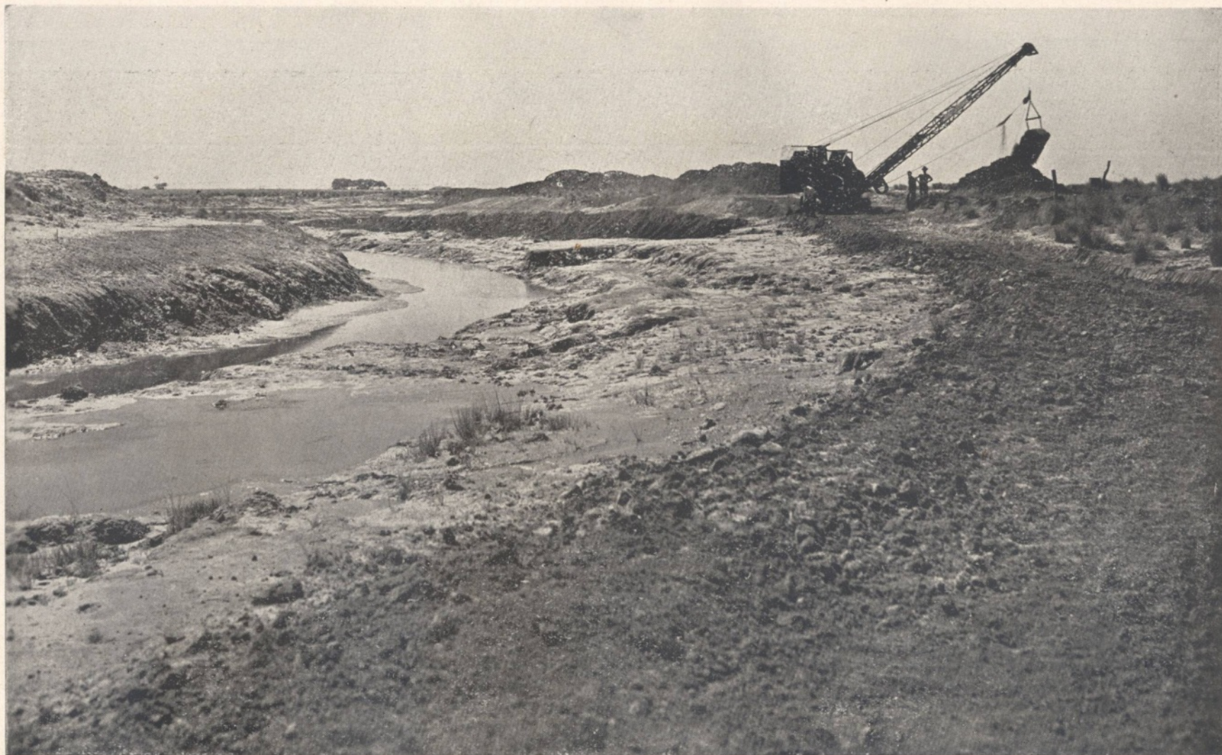
Máquina Excavadora, propiedad de la Dirección de Obras Públicas de la Provincia, excavando en las cañadas Romero y Corralito
