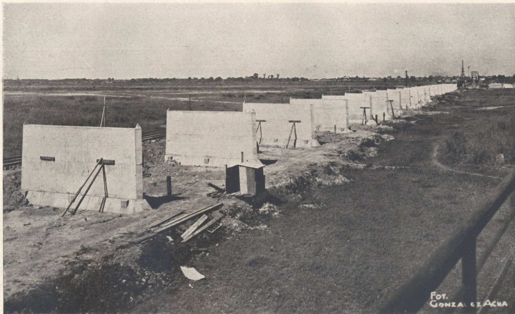
Pilares para vigas Gerber, de hormigón armado, en el puente sobre el Río Salado, camino de Santa Fe a Rosario
