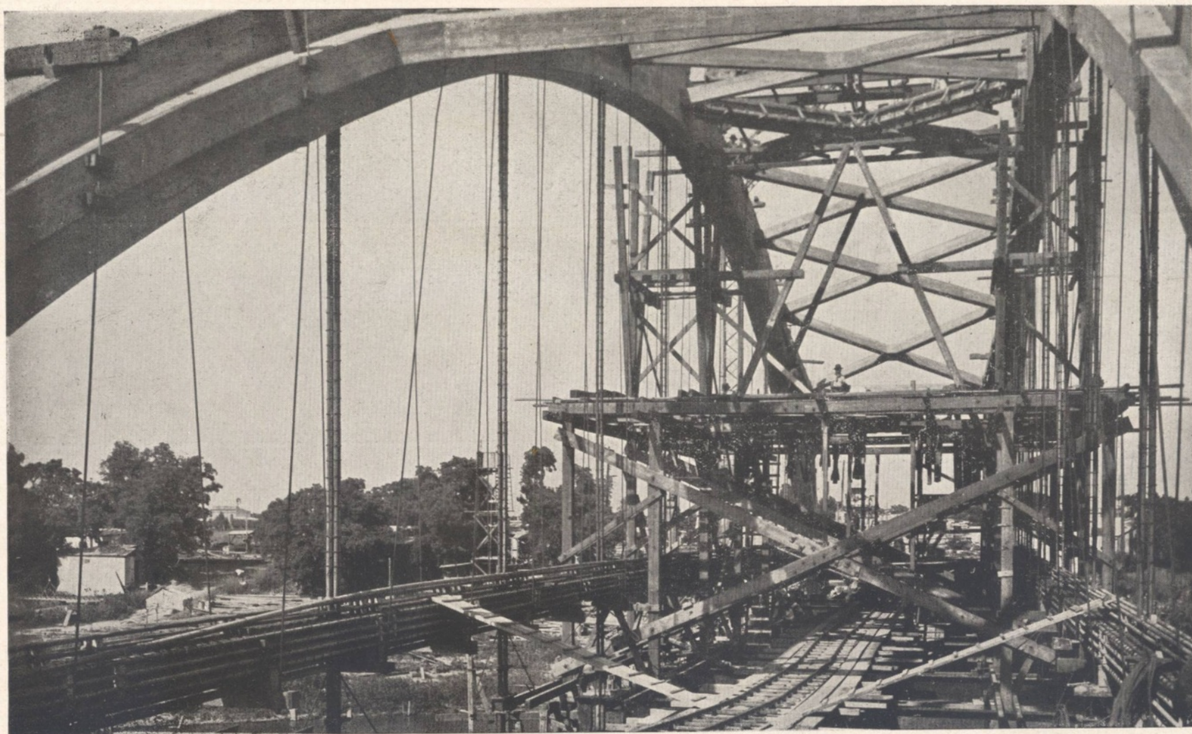
Interior del arco de hormigón armado, de 80 metros de luz, en el puente sobre el Río Salado
