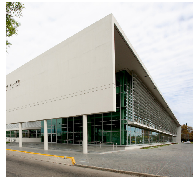
Hospital de Emergencia Clemente Alvarez Mario Coreia
