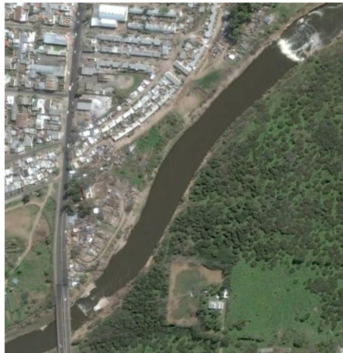
Figura 33: Distancia actual entre el puente Ayacucho y el salto
