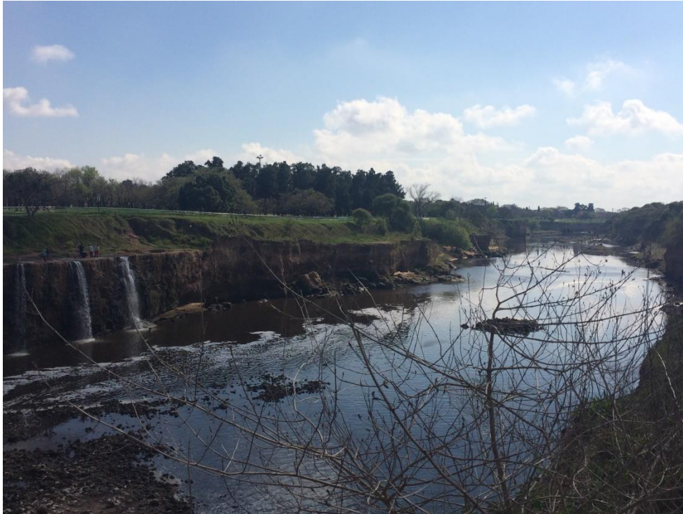
Figura 31: Fotografía donde se observan las barras del canal
