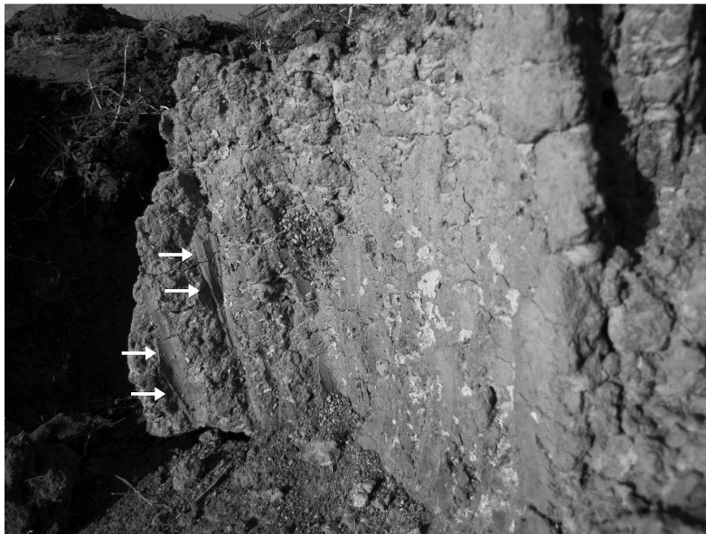
Figura 6. Detalles de surcos de confección en cara interna de la pared
