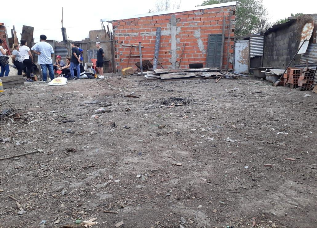
El mismo terreno luego de haber finalizado las tareas de limpieza.
