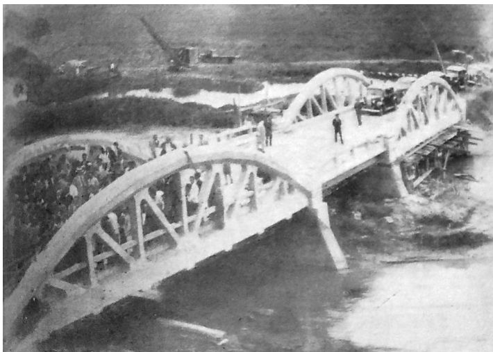
Imagen 1. Puente sobre el río Atuel (San Rafael).
