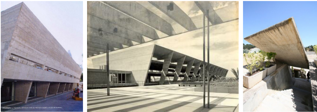
Figs. 180, 181 y 182 (de izq. a der.) Fotografía del Edificio Tiempos Modernos con disposición de pórticos de hormigón. Fuente: Revista ARQ, n. 55 (diciembre, 2003); Fotografía del proyecto del Museo de Arte Moderno de Río de Janeiro del arquitecto Affonso Eduardo Reidy. Fuente: https://www.archdaily.com ; Fotografía del proyecto del Cementerio de Igualada de los arquitectos/as Enric Miralles y Carme Pinós. Fuente: www.archdaily.com , Fotografías de David Cabrera
