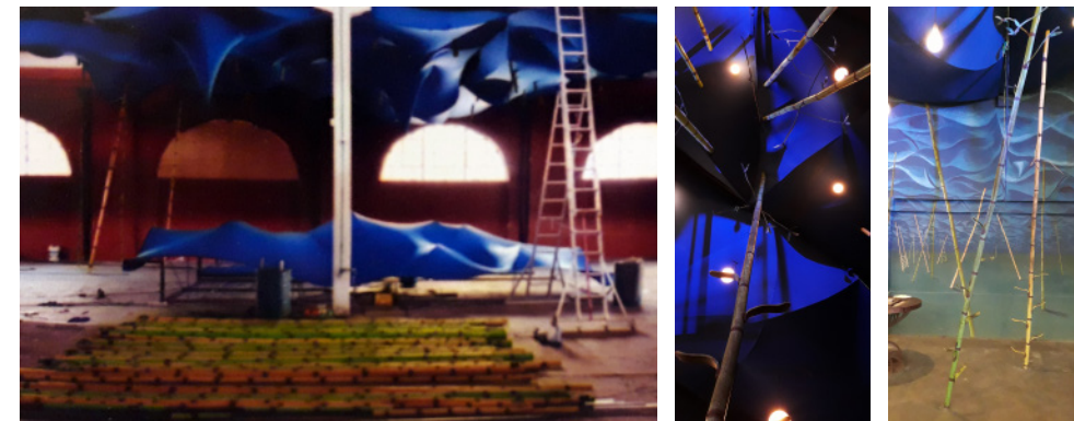
Fig. 441 y 442 (de izq. a der.) Fotografía de las cañas estructurales, parte del cielorraso instalado y parte a montar. Fuente: Archivo personal Mauro Musante (consultado septiembre 2023). Figs. 445 y 446 (de izq. a der.). Fotografía de las cañas y cielorraso montado en la Isla; tubos redondos de hierro simulando cañas de bambú colocados en el DLP. Fuente: 2021, archivo personal.
