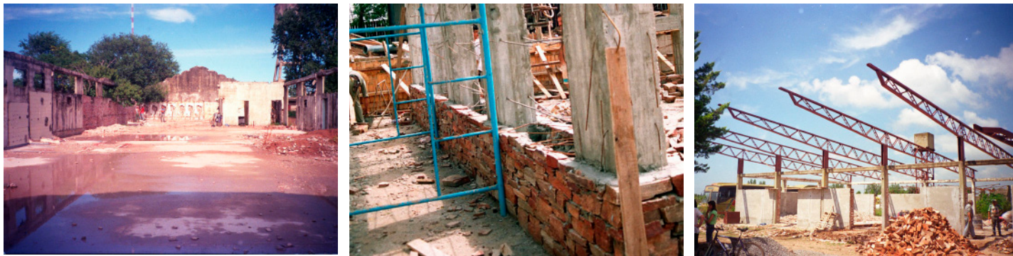
Figs. 115, 116 y 117 (de izq. a der.). Estado del edificio de la planta de reciclaje “9 de julio” con columnas de hormigón y cerramiento de mampostería cuando la arquitecta. Fierro visita el terreno (1997); Reciclaje de la estructura del edificio y obra al momento del proyecto de la Granja de la Infancia. Fuente: Archivo personal de la Arq. Paula Fierro; Fotografía durante obra para el Edificio Sede con estructuras en hormigón y vigas metálicas para expansión semi-cubierta (1998). Fuente: Paula Fierro.
