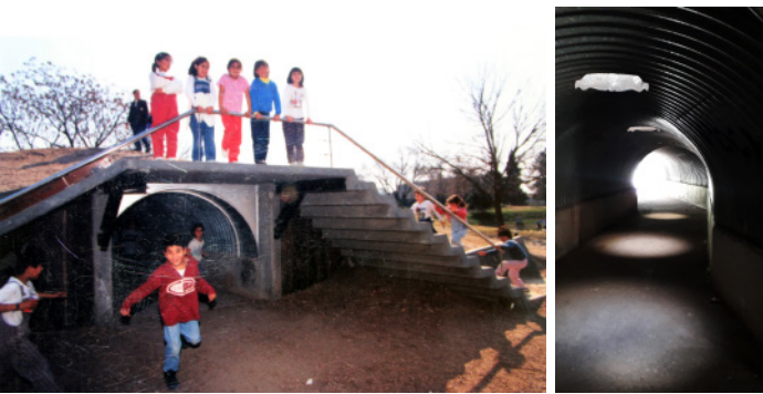
Figs. 282 y 283 (de izq. a der.) Fotografía del túnel de la Granja de la Infancia al momento de la inauguración. Fuente: Carpeta institucional de la Granja de la Infancia, consultado en abril 2024. Fotografía de las aberturas en el túnel de la Granja para iluminación cenital. Fuente: 2023, archivo personal
