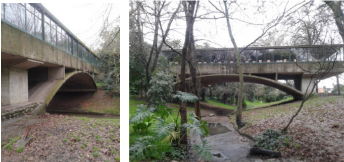
Figs. 49 y 50 (de izq. a der.) Fotografías exteriores de la casa sobre el arroyo de Williams y Gálvez Bunge donde se evidencia la articulación con las lomas de tierra, césped y arroyos. Fuente: 2017, archivo personal.
