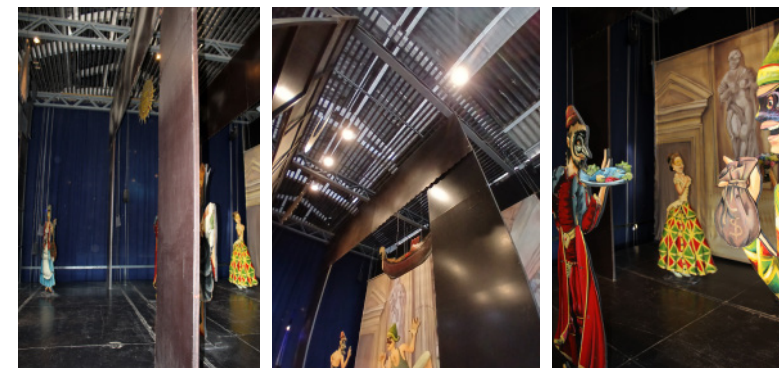
Figs. 420, 421 y 422. (de izq. a der.) Fotografías de la estructura superior a modo de “parrilla” donde se monta la escenografía y rieles; Fotografía de los diferentes personajes realizados en madera con estructura para montaje y escenario. Fuente: 2024, archivo personal.
