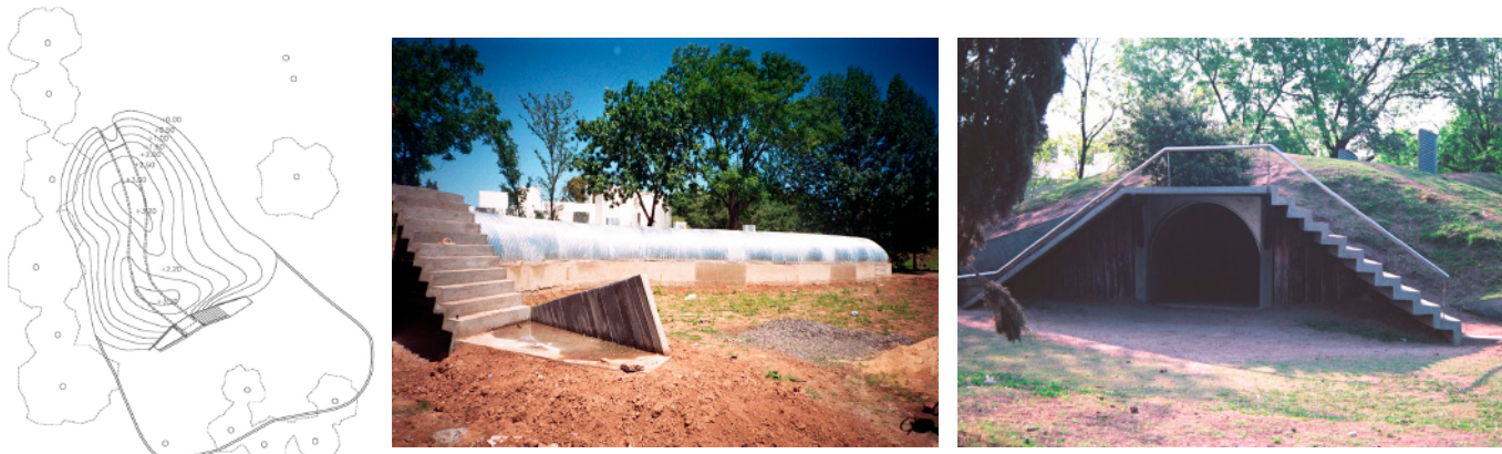
Figs. 284, 285 y 286 (de izq. a der.) Planta del túnel de la Granja de la Infancia. Fuente: 2024, elaboración propia sobre documento de la arquitecta Fierro; Fotografía de la estructura del túnel antes de cubrir con montículo de tierra y césped. Fuente: Archivo Paula Fierro (recuperado septiembre 2022); Fotografía del túnel una vez inaugurada la Granja; Fuente: Carpeta institucional de la Granja de la Infancia, consultado en abril 2024.
