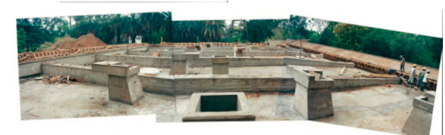
Figs. 165 y 166 (de izq. a der.) Planta definitiva del proyecto para el Edificio “Tiempos Modernos” y “Calle de los Sucesos”; Esquema de los pórticos diseñados, con doble losa de hormigón y vigas invertidas; Fotografía de la losa de la cubierta del Edificio “Tiempos Modernos” con vigas invertidas. Fuente: Compilación realizada por el arquitecto Bechis.
