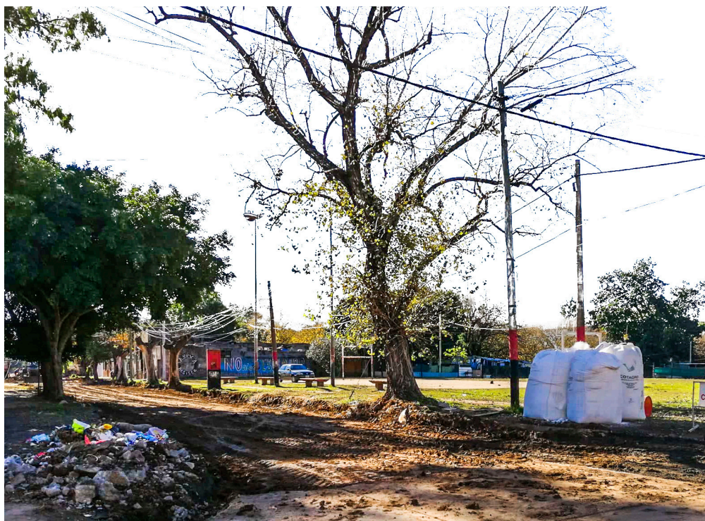
Fig.15: Relevamiento fotográfico. Esquina Beruti y Cerrito
