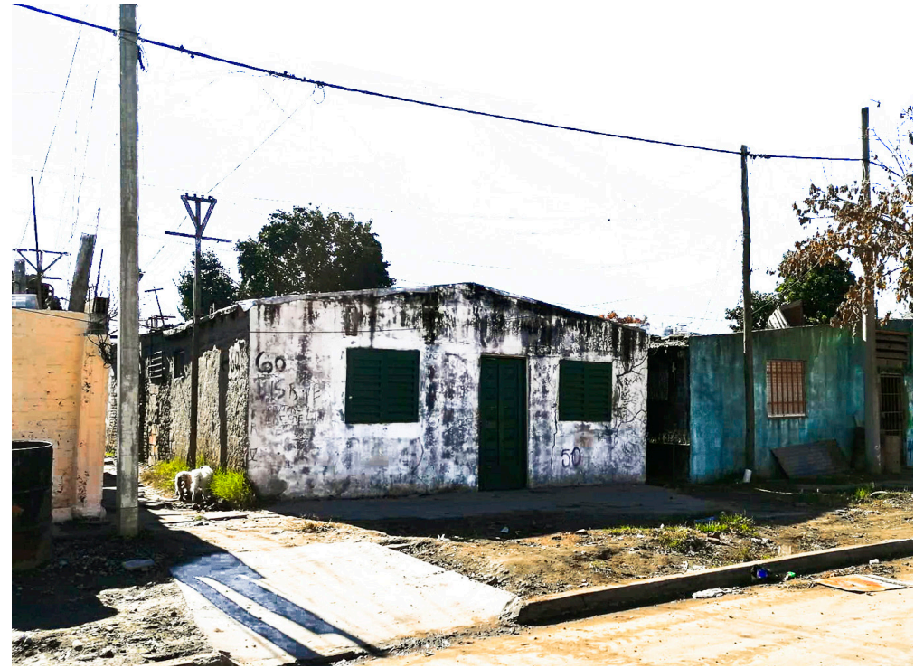
Fig.18: Relevamiento fotográfico. Calle Beruti
