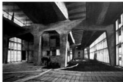
Gio Ponti, P.L.Nervi. Torre Pirelli, Milán, Italia (1950-1960). Detalles del sistema estructural, imagen de los porticos resistentes. Fuente: Pier Luigi Nervi, a cura de Desideri Paolo, Nervi Pier Luigi Jr, Positano Giuseppe. Colección Serie di Architettura, Zanichelli. Primera edición 1979
