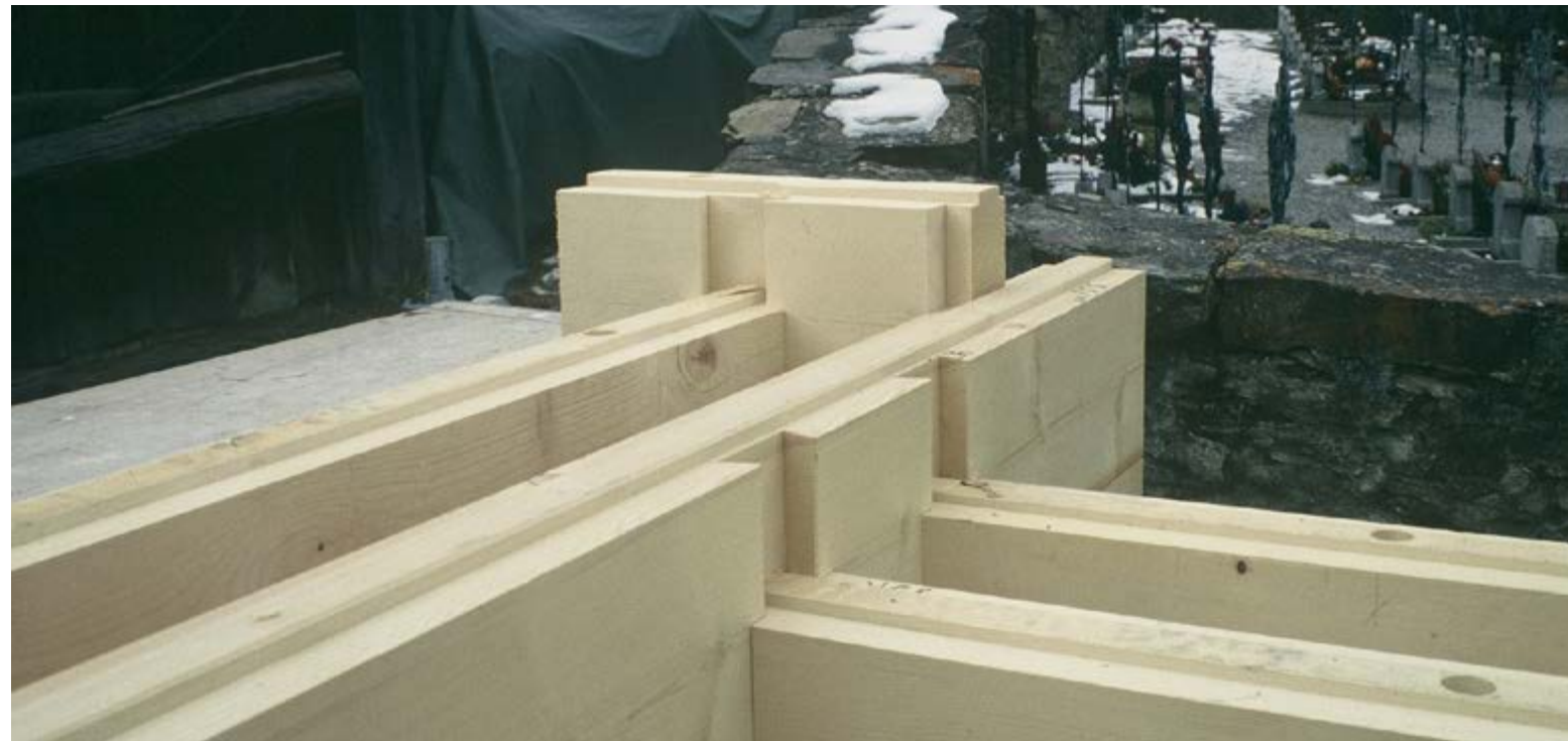
Detalle de obra. Foto: Estudio Caminada-Vrin
