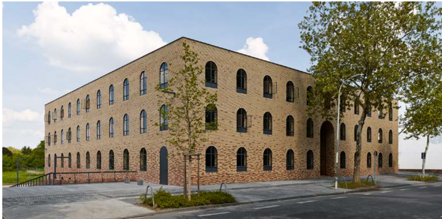
ROM.HOF. Frente sobre la calle / Il fronte su strada. Foto, Stefan Müller. Berlín
