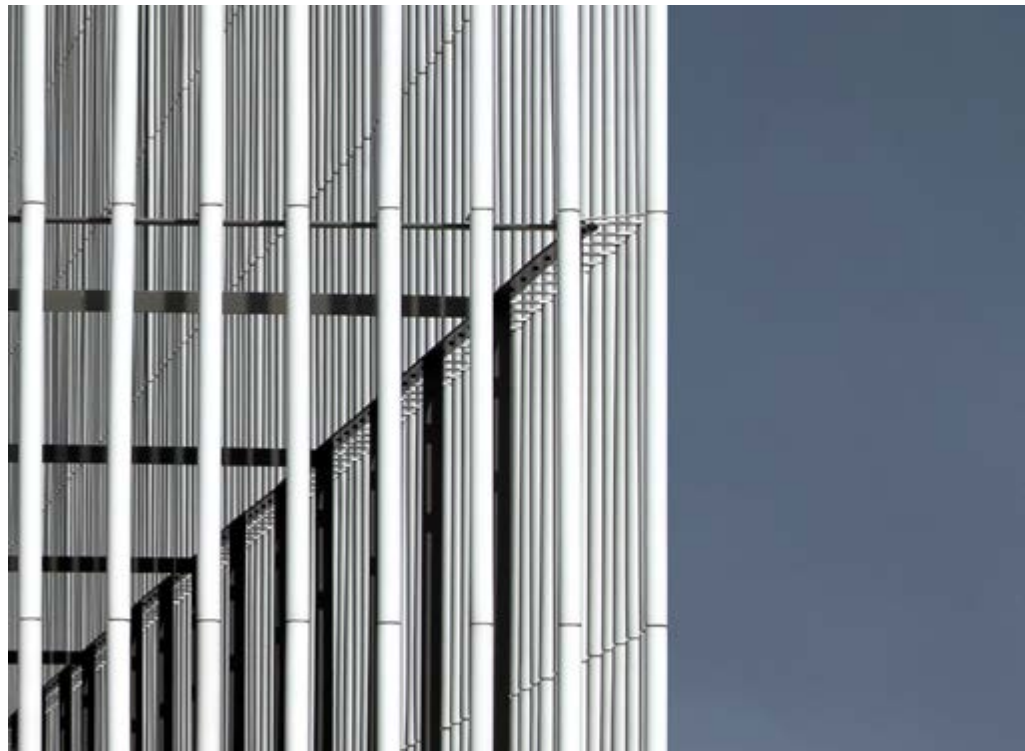
OAB, Biblioteca municipal en Vila Real, Castellón, Comunidad Valenciana, España (2009-2011). Espacio intermedio entre la cortina cerámica de fachada y el interior del edificio. Foto ©Alejo Bagué
