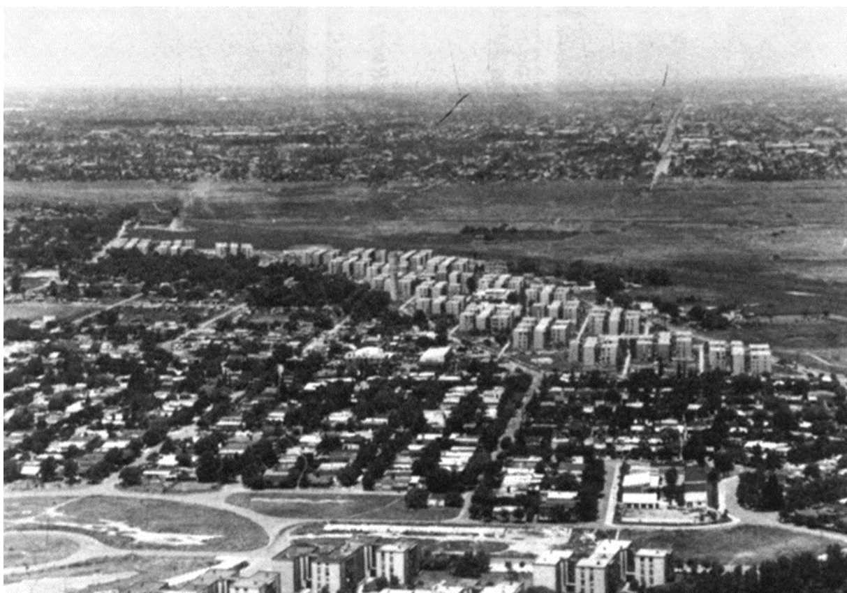
Figura 100: Foto aérea enfocada hacia el sur. En primer término bloques de Barrio Rucci , detrás Parquefield y luego Parque Field 2 . En Caprini, E. (1986), p. 55.
