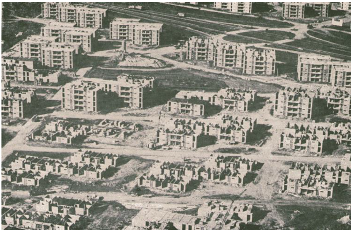
Figura 84: Barrio Rucci en construcción. Revista Nuestra Arquitectura 499, 1977.
