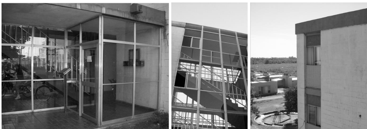
Figura 86: Vistas cercanas bloques Barrio Rucci
