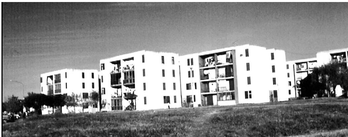
Figura 101: Bloques de Parque Field 2 , a poco de ser ocupados
