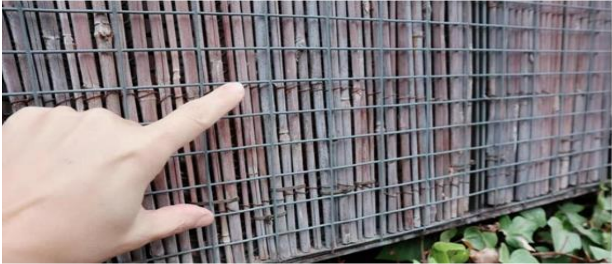
Figura 33. Panel de bambú con rejilla de metal
