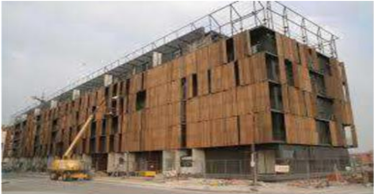
Figura 34. Proceso constructivo del edificio Carabanchel
