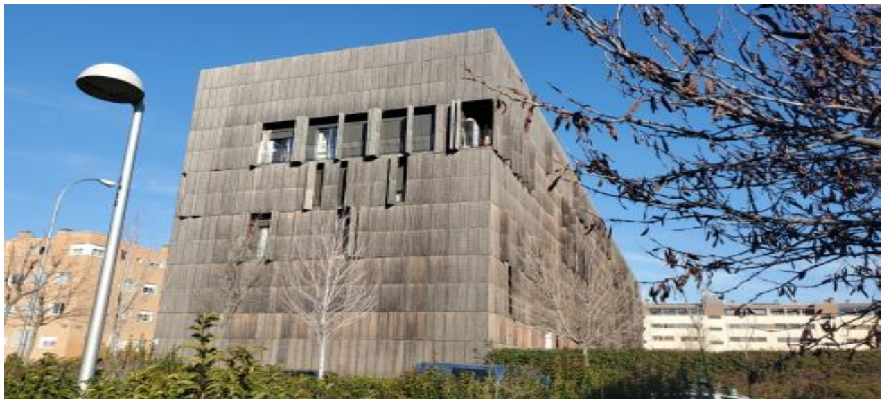
Figura 28. Edificio Bambú en Carabanchel – Madrid
