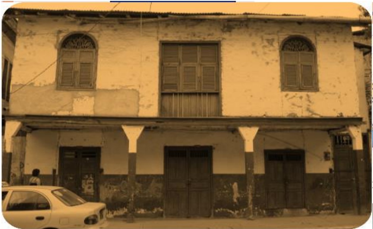
Figura 117. Casa Wilfrido Loor antes de la restauración
