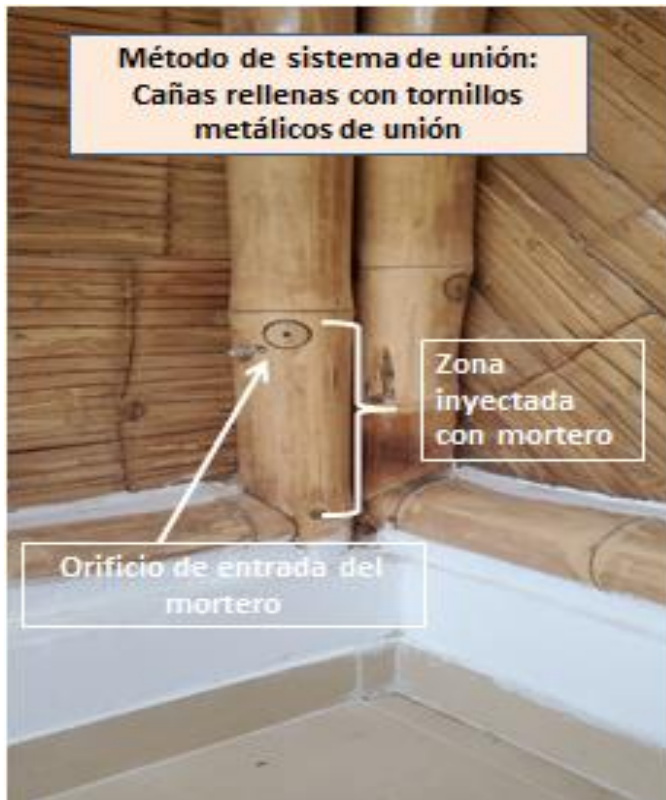
Figura 37. Método de Simón Vélez aplicado a la Proyecto Ciudades ODS. Ecuador
