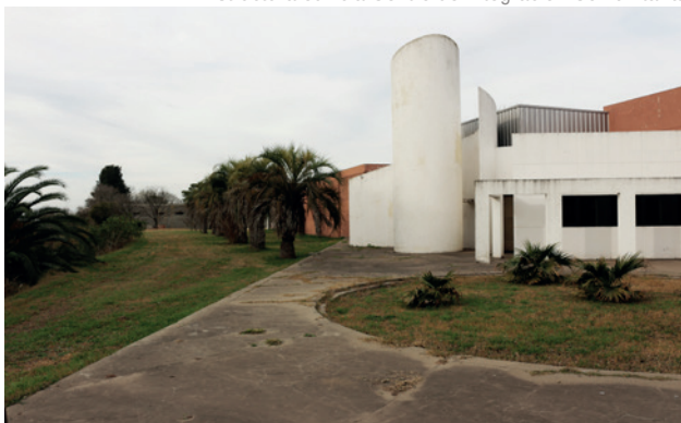
Edificio preexistente. Museo Municipal. Ubicado en el margen del Arroyo
