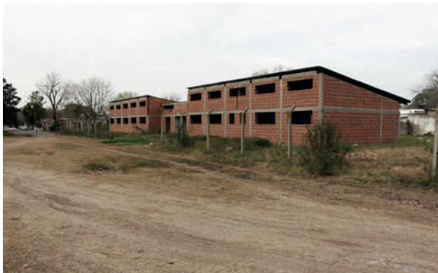
Estructura edilicia Centro de Integración Comunitaria
