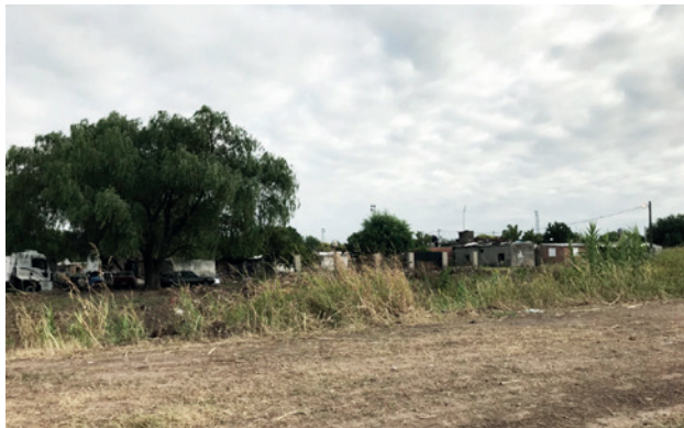
Viviendas irregulares ubicadas en terrenos públicos al borde del Arroyo
