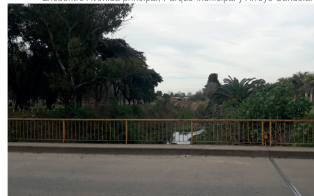
Cruce Arroyo Candelaria y Avenida principal de acceso a la ciudad
