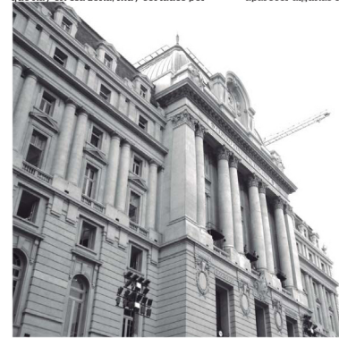
CENTRO CULTURAL KIRCHNER: INGRESO PRINCIPAL DURANTE LA OBRA
