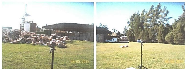
FIGURA 8. Registro fotográfico durante la toma de muestra N° 3.
