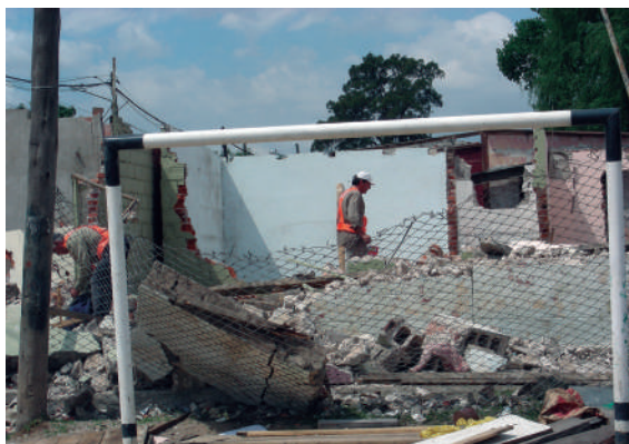
2. "Construcción-destrucción". NHT Zavaleta. CABA , 2007. Foto: Vanina Lekerman.
