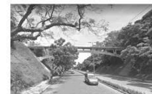
Puente peatonal sobre Av Pellegrini
