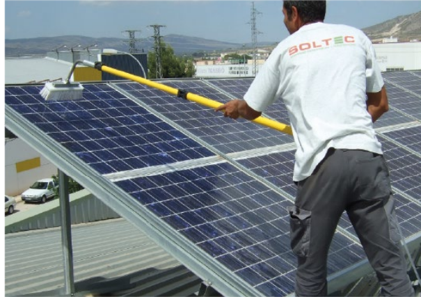
Figura 123 Limpieza de paneles fotovoltaicos ( https://soltecvillena.com/servicios/ )
