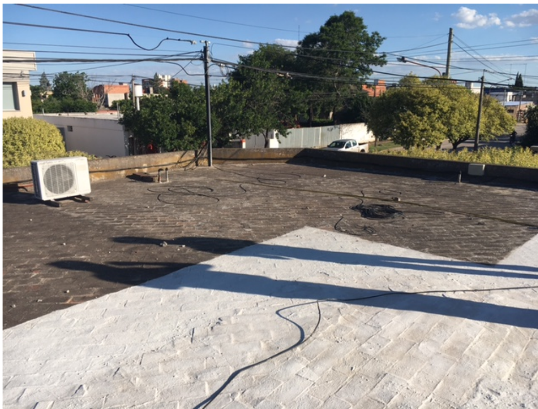
Figura 108 Relevamiento fotográfico del tipo de acabado de la superficie de la cubierta de una vivienda seleccionada, en la ciudad de Armstrong, Santa Fe (fotografía de autoría propia)
