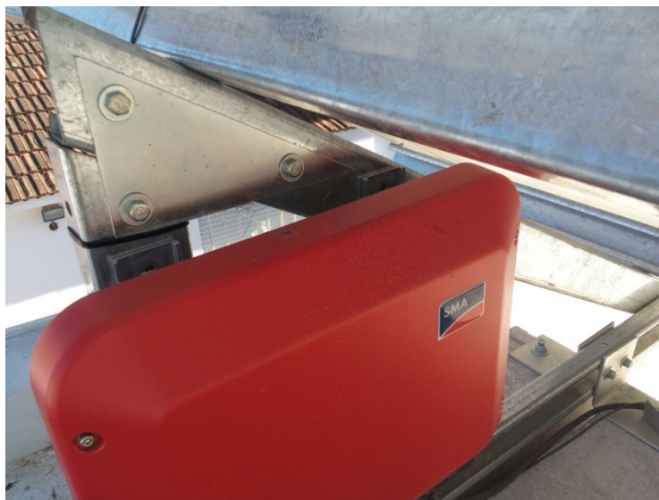
Figura 116 Colocación de inversor en la estructura metálica (fotografía de autoría propia)
