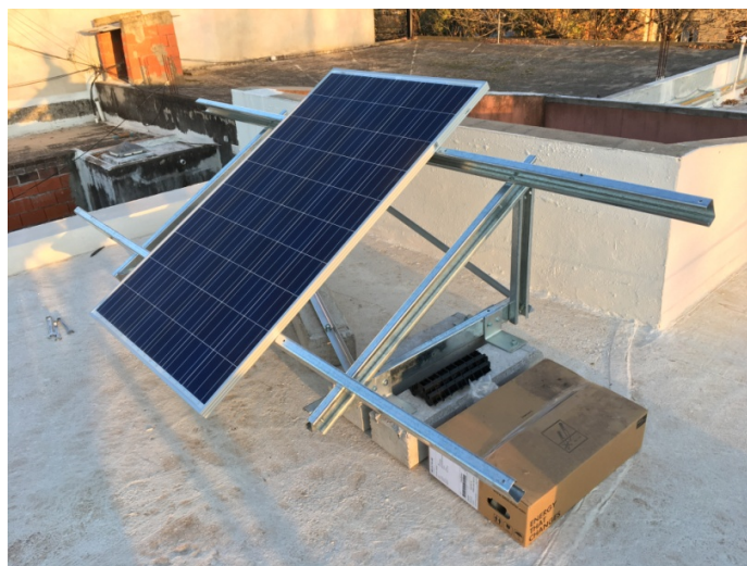
Figura 115 Armado de mesa de paneles FV (fotografía de autoría propia)
