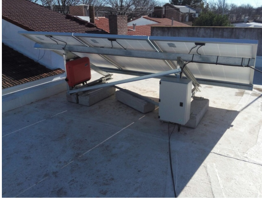
Figura 92 Diseño final de mesa de paneles fotovoltaicos (fotografía de autoría propia)
