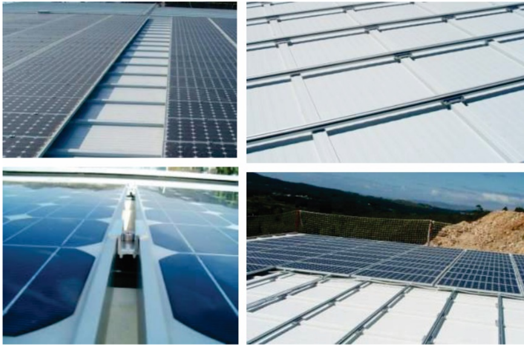
Figura 71 Instalación fotovoltaica sobre cubierta inclinada de chapa. Nave ECO FLOAT. A. Coruña, España ( https://www.buenosaires.gob.ar/sites/gcaba/files/documents/sistemas_fotovoltaicos_aplicados_a_la_arquitectura.pdf )
