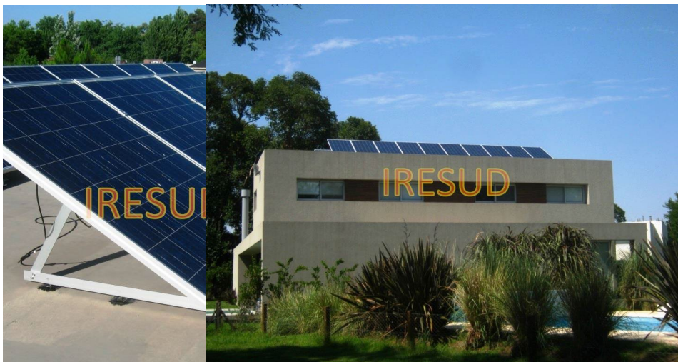
Figura 73 Instalación directa de la estructura portante sobre cubierta plana con terminación de membrana transitable en vivienda unifamiliar. Parque Leloir, Buenos Aires, Argentina (Iresud)
