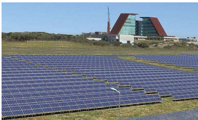
Figura 24 Planta solar del proyecto GENREN en Terrazas del Portezuelo, San Luis ( https://www.facebook.com/pg/parqueterrazasdelportezuelo/posts/ )
