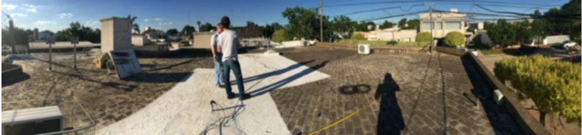
Figura 103 Panorámica de cubierta preseleccionada de una vivienda en la ciudad de Armstrong, Santa Fe, que permite relevar y documentar posibles elementos externos a la edificación que puedan producir sombras (fotografía de autoría propia)
