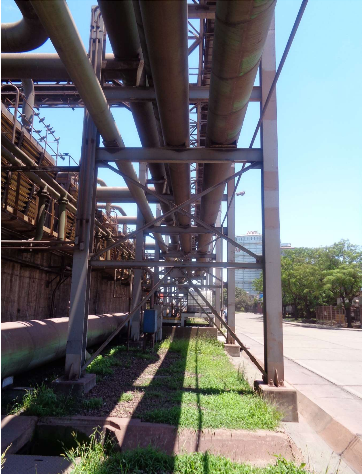
Figura 16 - Empotramiento en una dirección
