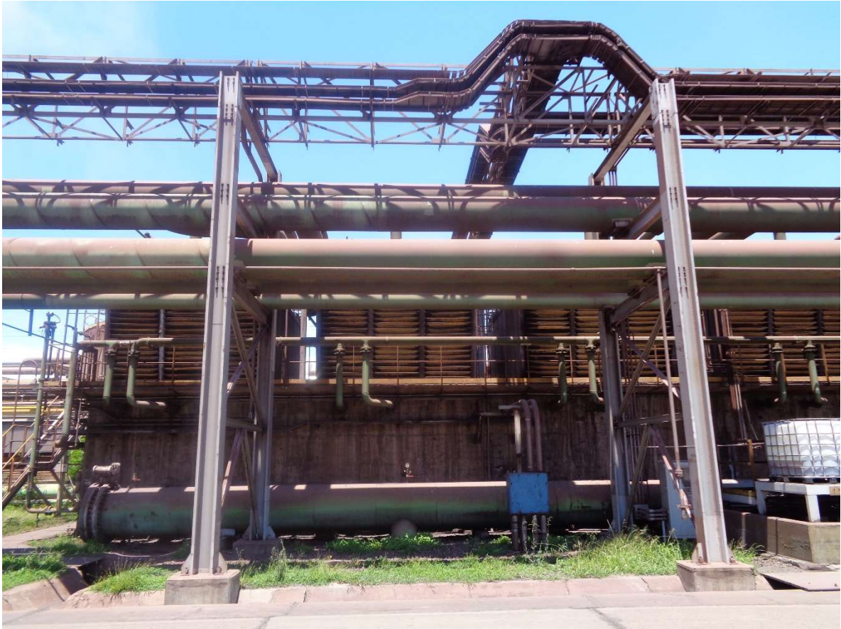
Figura 17 - Empotramiento en una dirección
