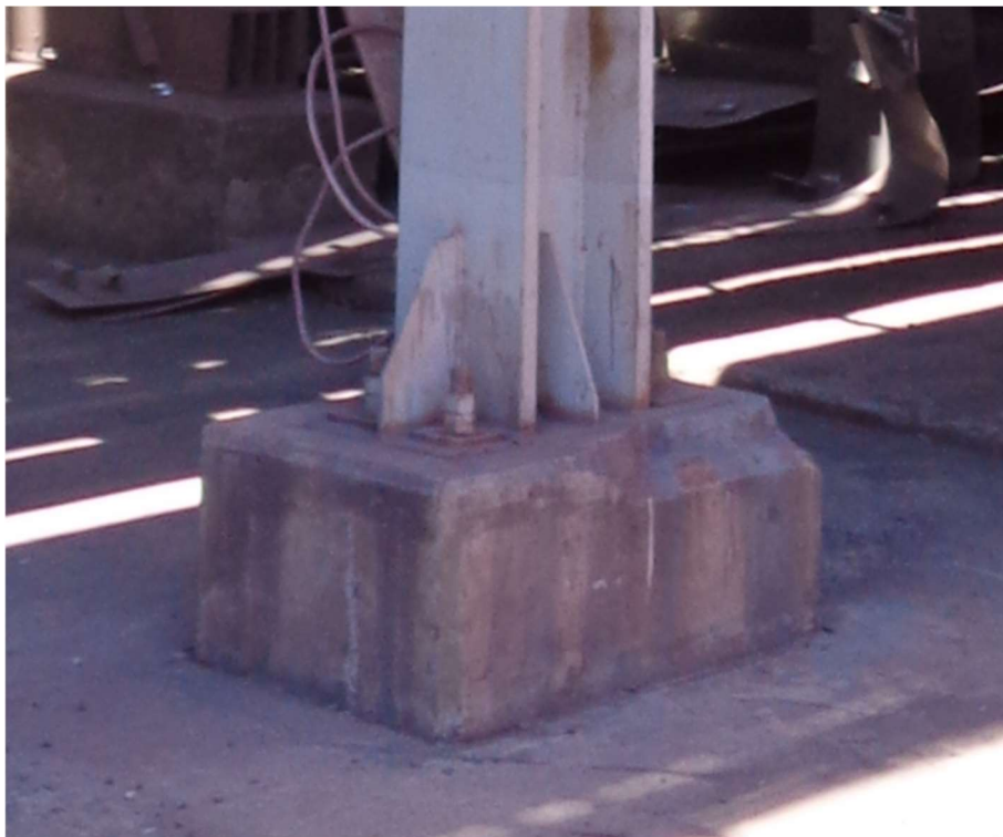
Figura 18 - Empotramiento en una dirección
