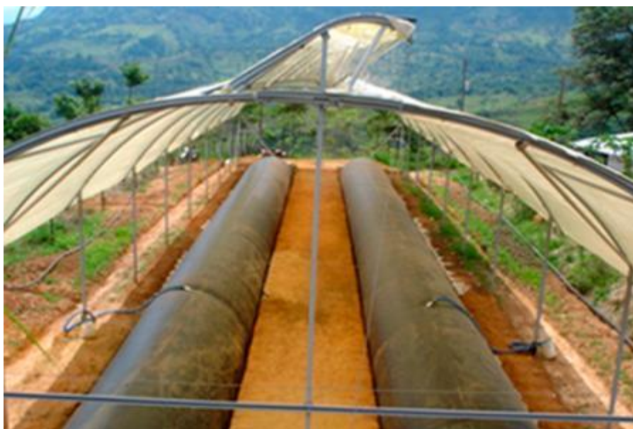
Figura. 5.9.3.4.2.1.1: Biodigestor tipo taiwanés.
