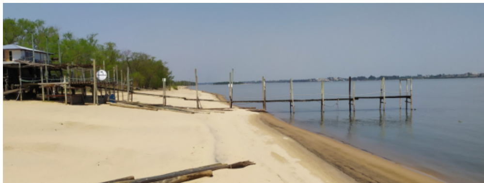
Imagen 10. Muelle N° 4 (Parador "Sudestada"). Imagen suministrada por el ENAPRO. Fecha 23/09/2020. Nivel hidrométrico de la fecha: +0,9 m.
