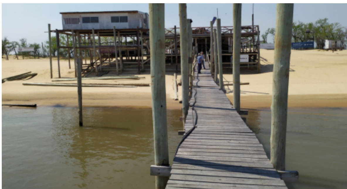
Imagen 6. Muelle N° 2 (Muelle del parador “Deja Vu”). Imagen suministrada por el ENAPRO. Fecha 23/09/2020. Nivel hidrométrico de la fecha: +0,9 m.
