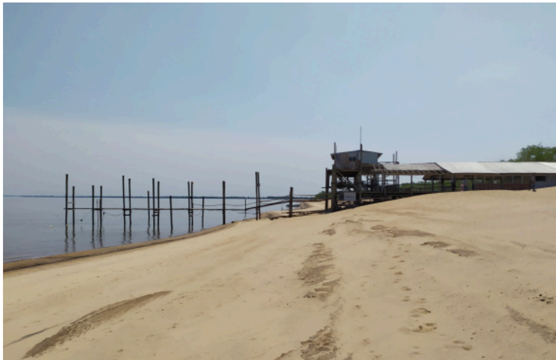
Imagen 7. Muelle N° 2 (Muelle de parador “Deja Vu”). Imagen suministrada por el ENAPRO. Fecha 23/09/2020. Nivel hidrométrico de la fecha: +0,9 m.
