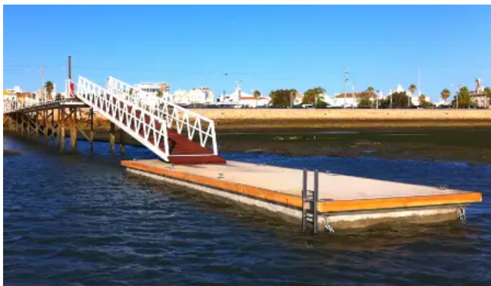
Imagen 28. Pantalán de hormigón armado. Fuente: Marinas y Puertos Deportivos Lindley.
