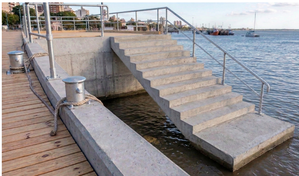
Imagen 23. Escalera de hormigón. Fuente: Imagen generada mediante inteligencia artificial.
