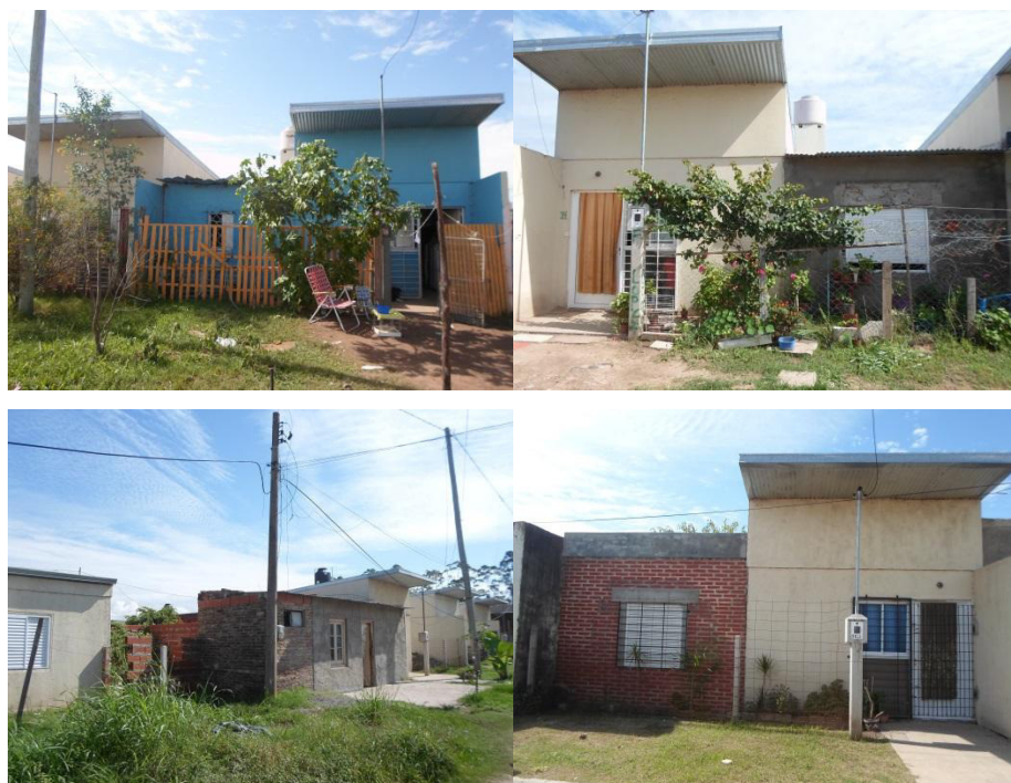
Fotografía 3 Ampliación viviendas en CD, Santa Fe, 2017.
