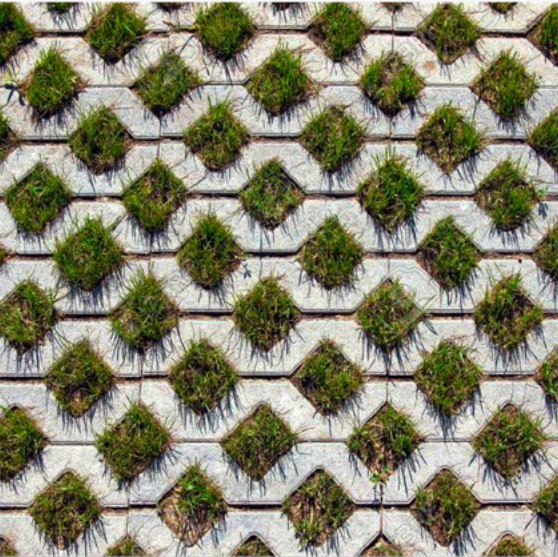
loseta cribada de hormigón
