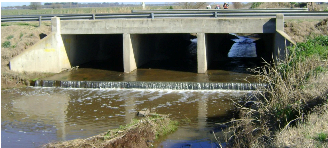
Figura N°8: Alcantarilla 021 La Legua. Año 2012. Fuente: DNV.
