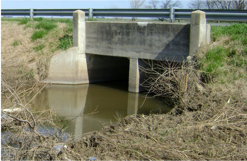
Figura N°7: Alcantarilla 020 La Carmelita. Año 2012. Fuente: DNV.
