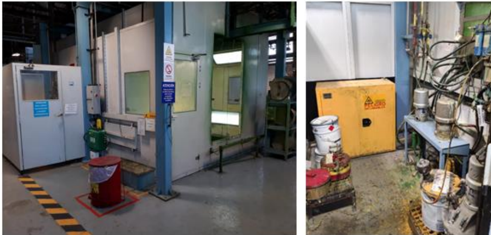
Imagen 122: Fotografías ilustrativas del interior del Recinto Anexo a Cabina
