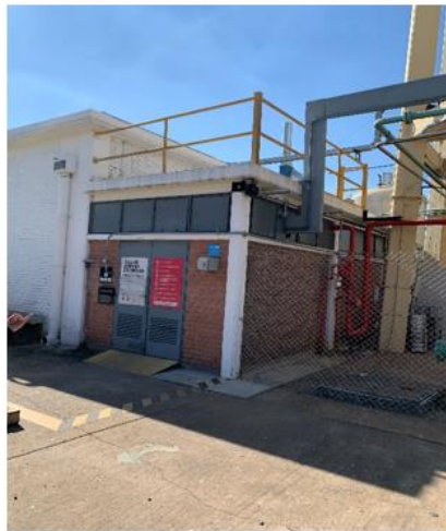
Exterior Cuarto de Dosificación de Pintura
