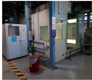
Exterior Recinto Anexo a Cabina de Pintura
