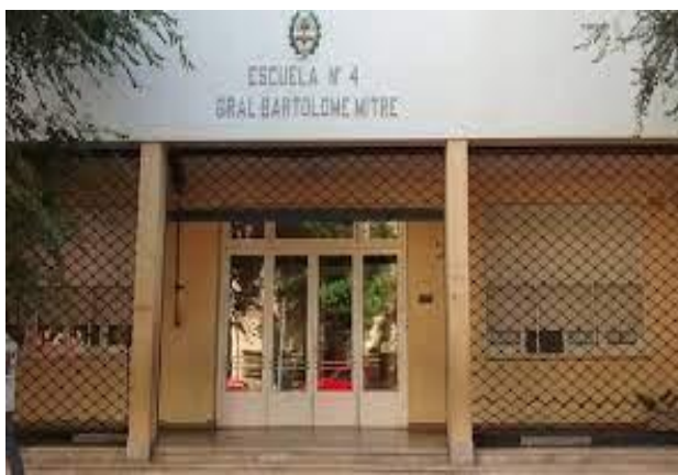
Figura 4 - EP N.º 4 Fachada https://www.facebook.com/p/Escuela-Primaria-4-
