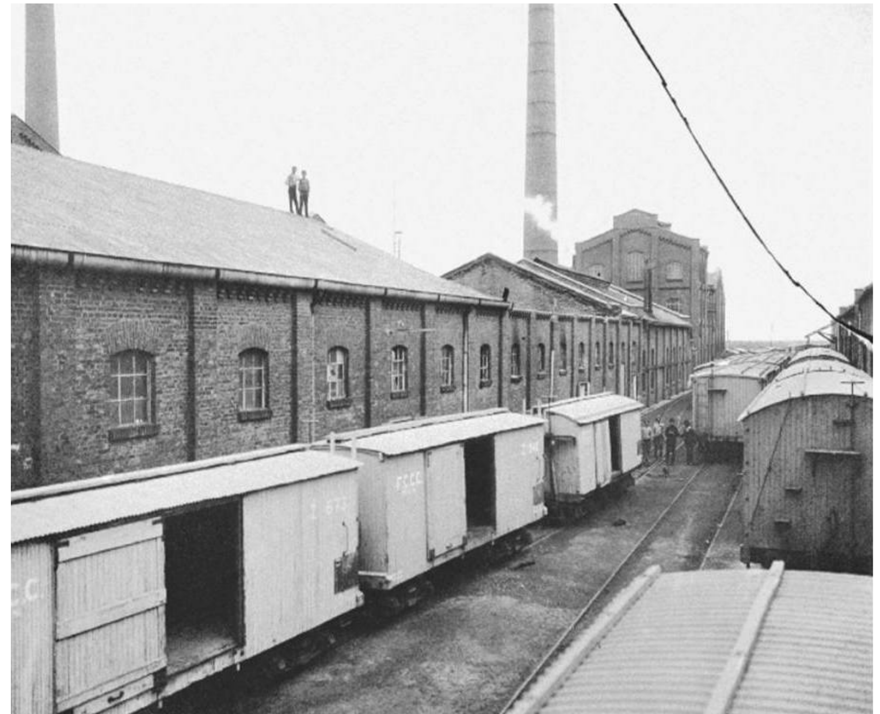
Vagones en los patios internos de la Refinería 1904
