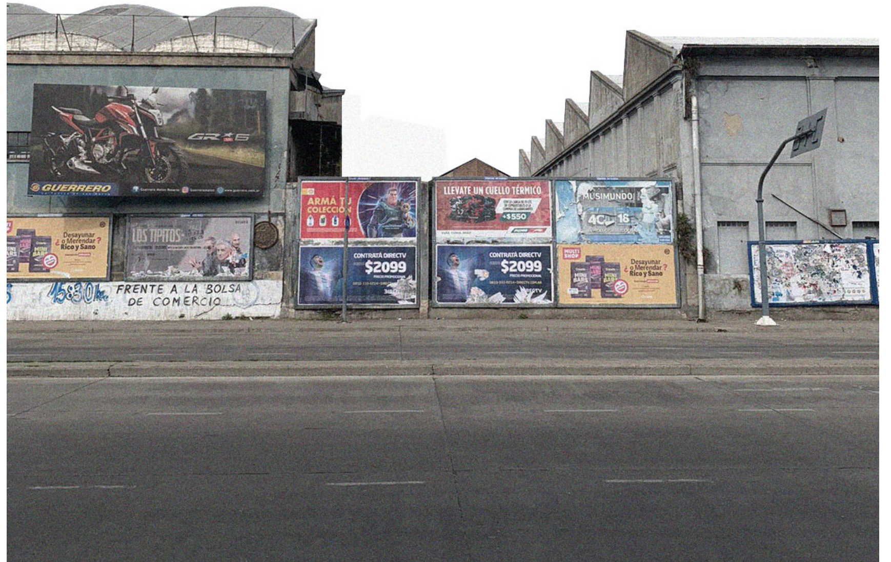
Fotografía actual de la Ex Fábrica Centenera El futuro pasaje 2023
