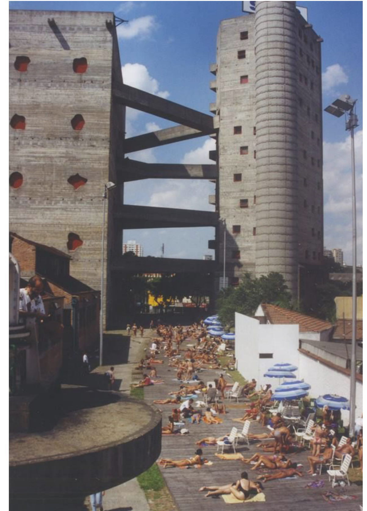
Solarium en zona no edificable
