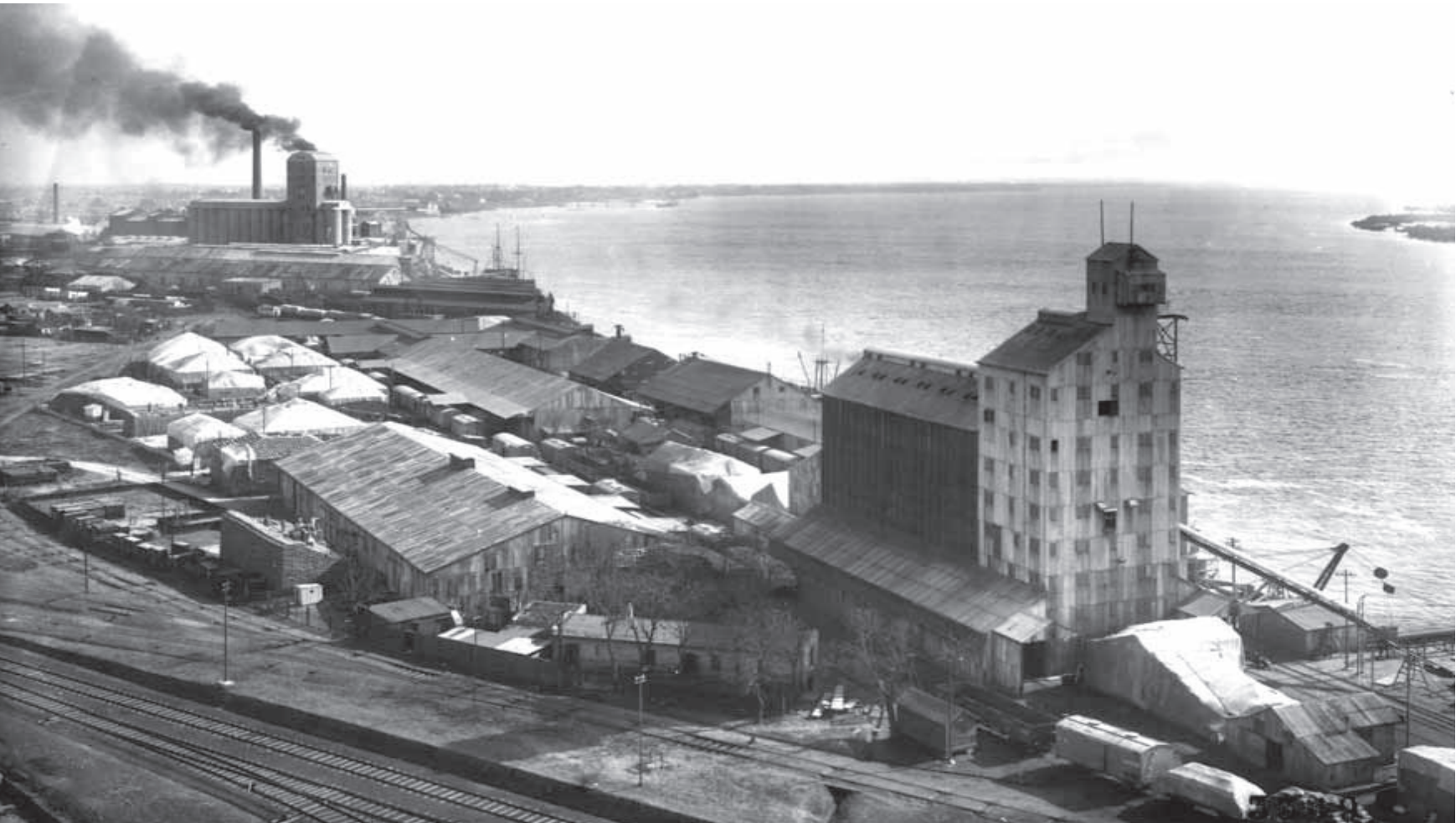
Vista del playón de acopio y elevadores de granos a la altura de calle Balcarce.
