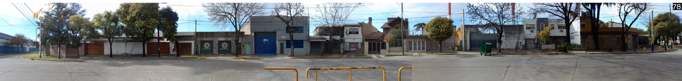
Fig. 78: Vista este, calle Ayacucho.
