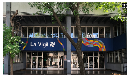
Fig 37: Edificio Administrativo de Vigil
