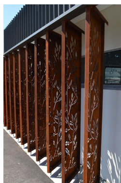
Fig. 152: Parasoles fijos y móviles material acero corten.
