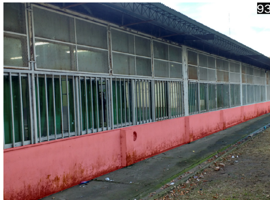
Fig. 93: Exterior ventanas de la Escuela Primaria.
