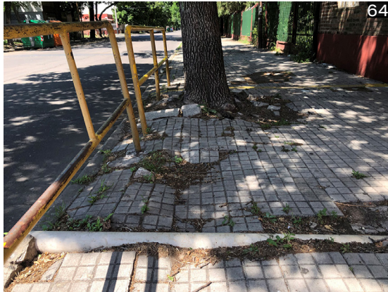
Fig. 64: Ingreso a Escuela Primaria, calle Ayacucho.
