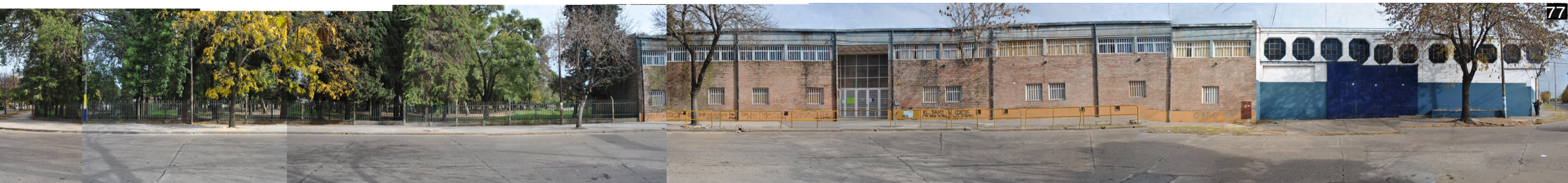
Fig. 77: Vista oeste, calle Ayacucho.
