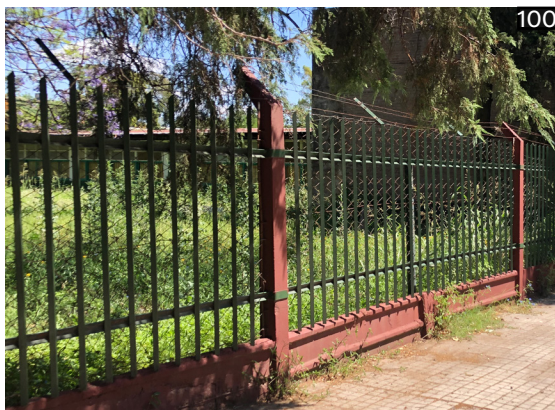
Fig. 100: Reja del patio-plaza.
