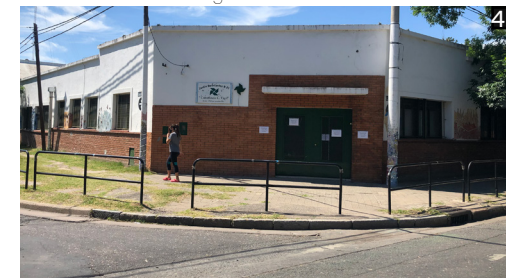
Fig 42: Edificio Jardin de Infantes N°51
