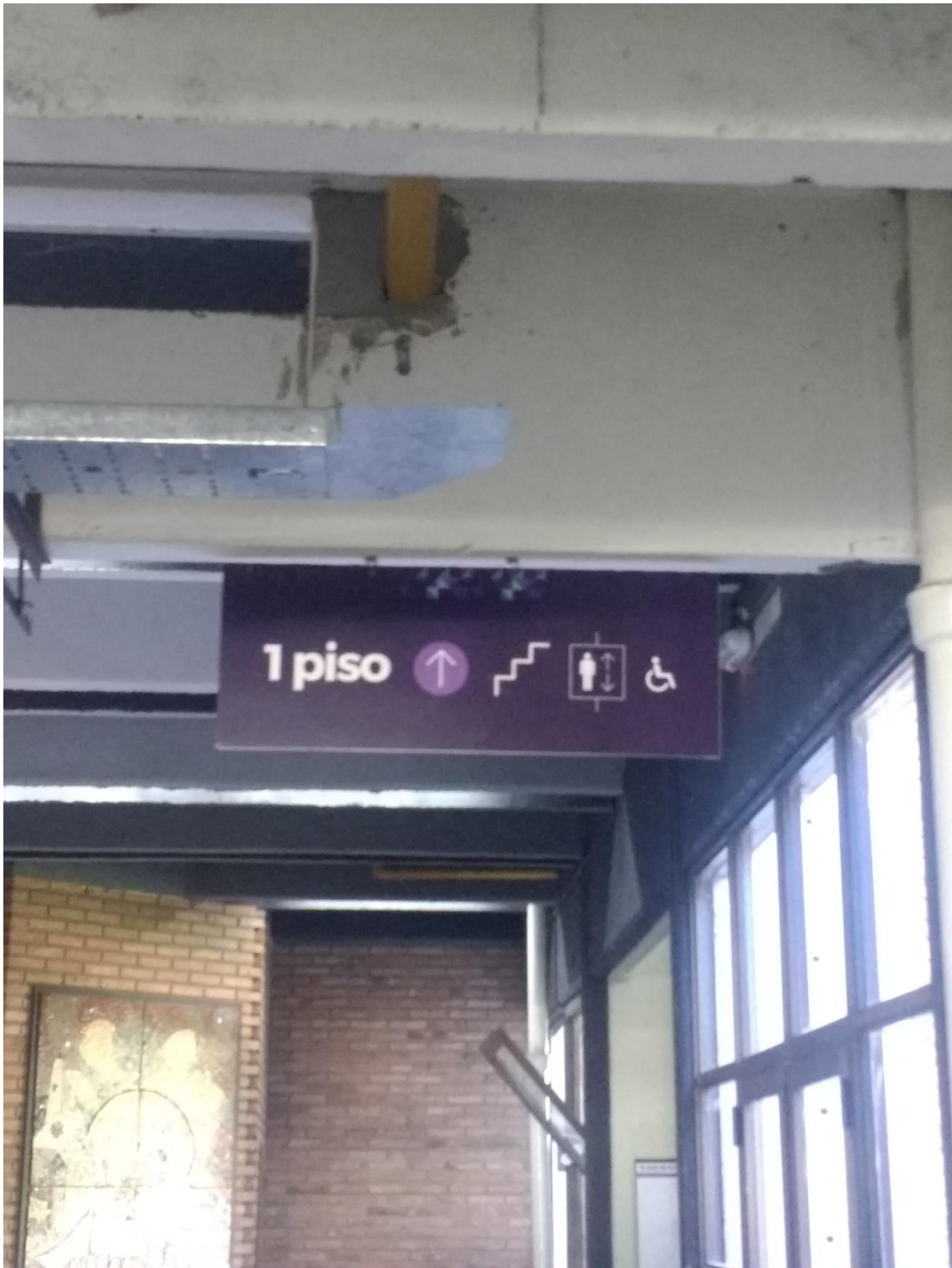
Figura 14. Fotografía señalética indicando acceso al primer piso de la FAPyD. Fuente: elaboración propia.
