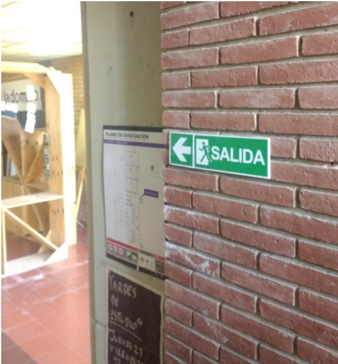
Figura 16. Fotografía cartel indicando salida de emergencia en planta baja del edificio de la FAPyD, junto a plano de evacuación. Fuente: elaboración propia.
