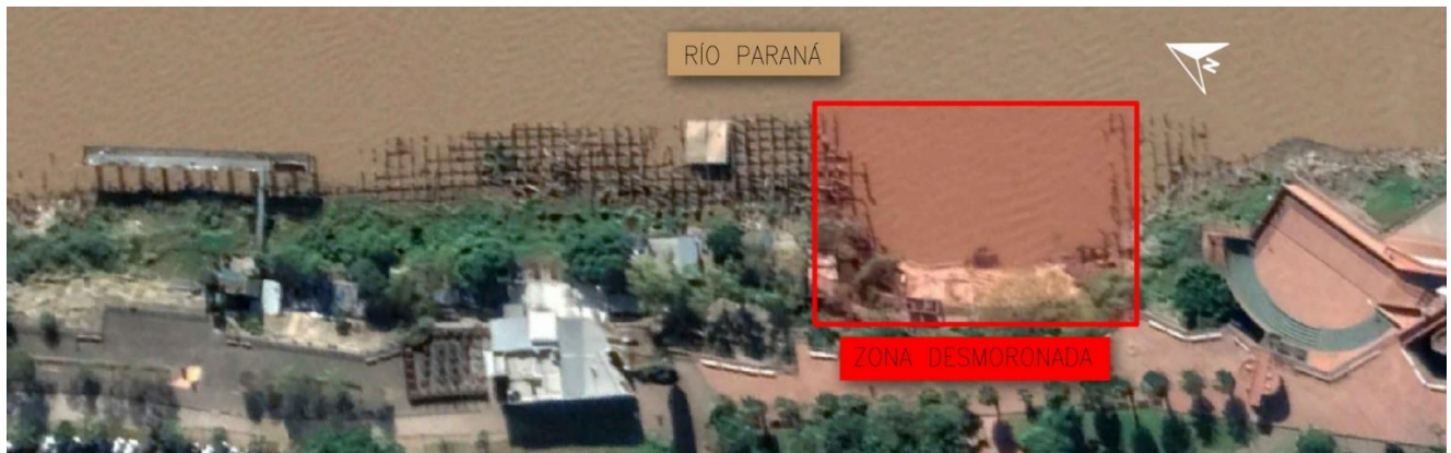
Ilustración 1.3-4. Imagen aérea posterior al deslizamiento (mayo 2021).
