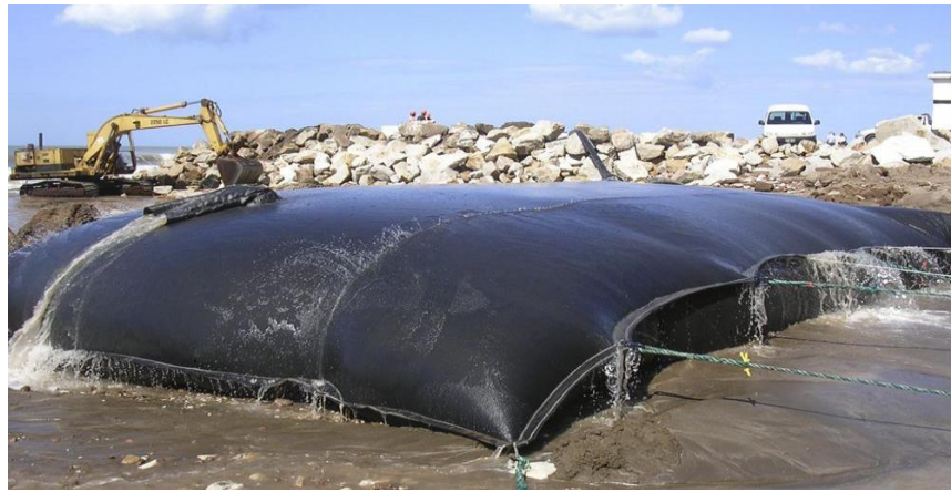
Ilustración 2.1-1 Geotubos rellenos con suelo.
