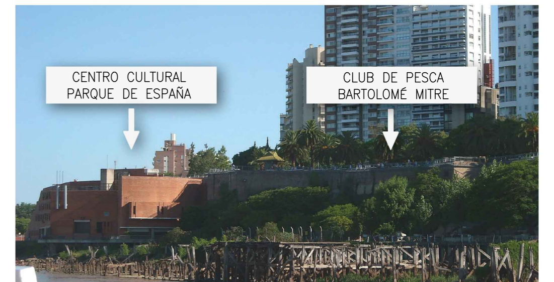
RESTOS DE ESTRUCTURAS DE ANTIGUOS MUELLES PUERTO ROSARIO (AÑO 2009).
