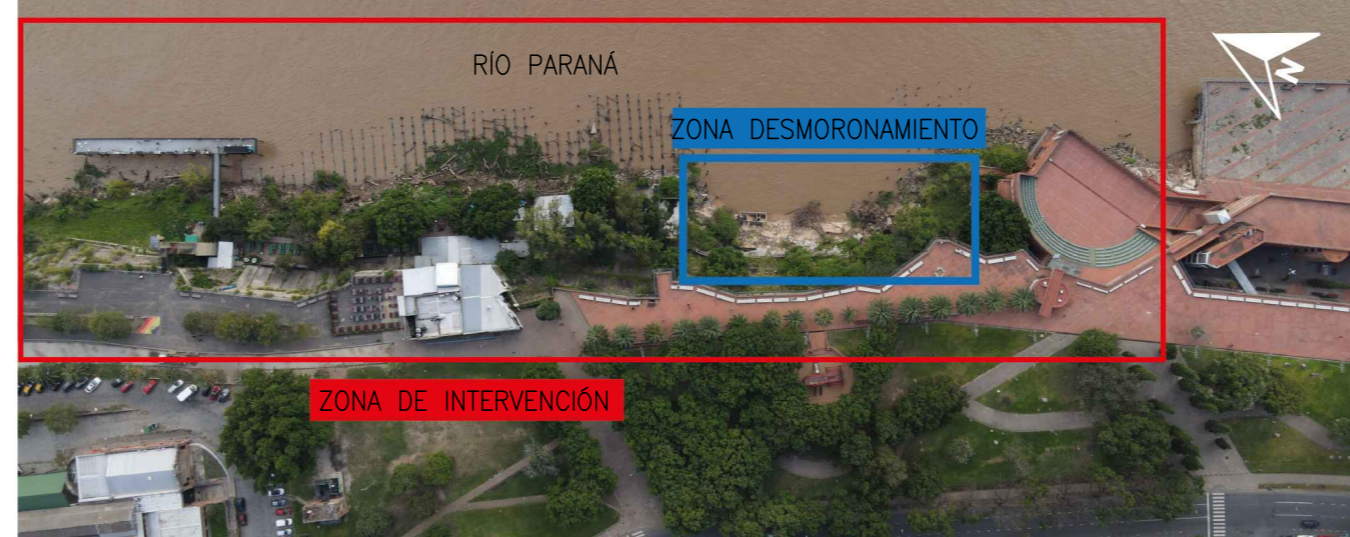
ARRIBA, SITUACIÓN DEL CLUB MITRE PREVIO AL DESMORONAMIENTO (IMAGEN AÑO 2009). ABAJO, SITUACIÓN ACTUAL DEL CLUB MITRE (IMAGEN AÑO 2024).
