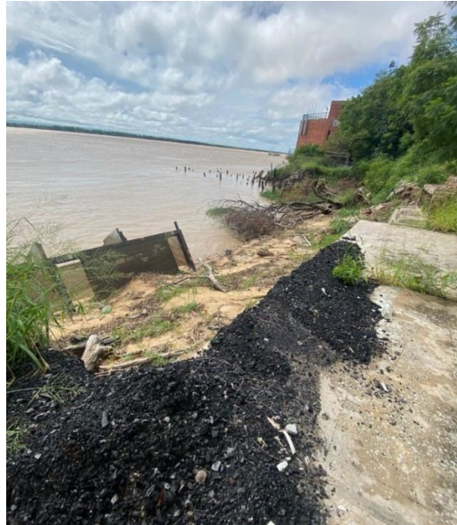
Ilustración 1.3-7. Situación actual vista desde la parte clausurada del club. Imagen propia.
