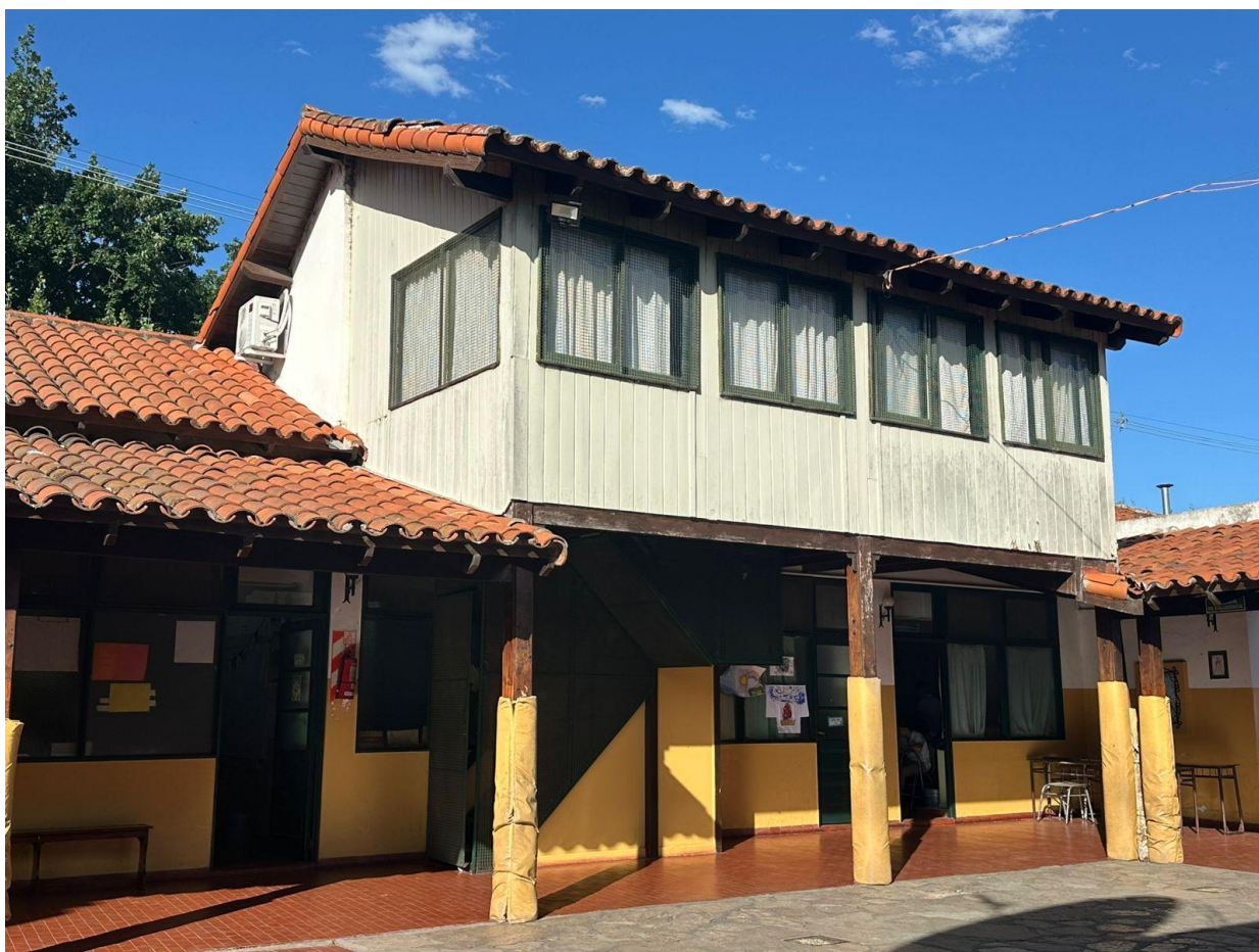
Fotografía tomada desde el patio central. Allí se observa el atillo donde se encuentra montada la radio escolar.
