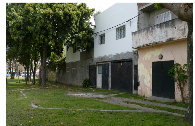
C • Medianera con Ingresos y Ventanas.
