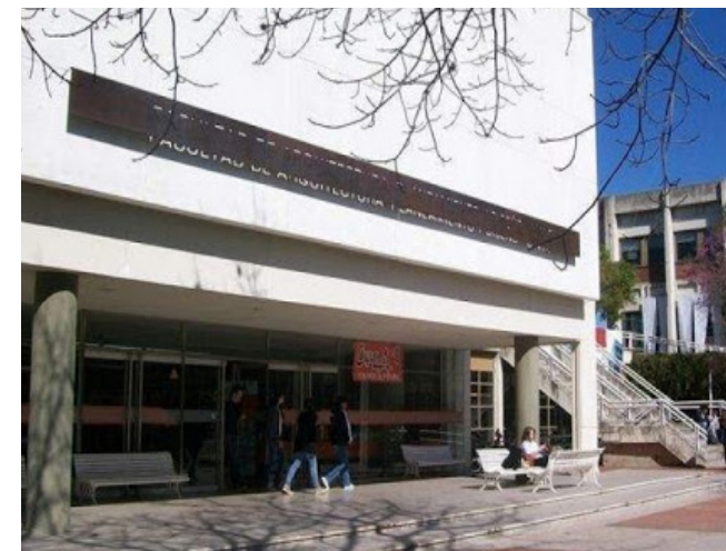
F • Facultad de Arquitectura.
