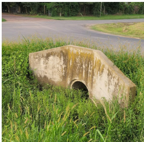
Figura 90. Alcantarilla existente, intersección calle Houssay y Rosales.
