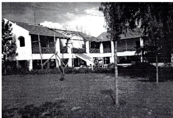
La escuela en construcción - 1991
