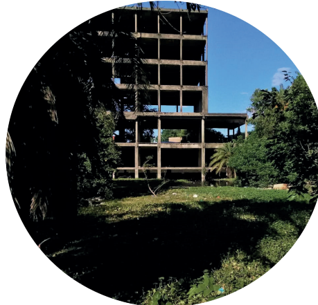
Estructura de Hormigón con pozo de agua
