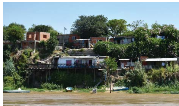
F6: Vivienda sobre pilotes. Foto tomada por las autoras
