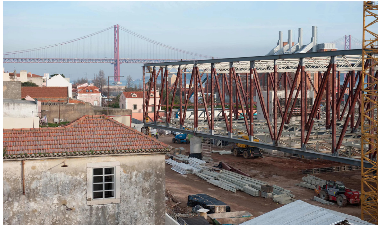
Museu dos coches, Lisboa. Paulo Mendes da Rocha. Fotografía del proyecto durante el montaje de la estructura metálica
