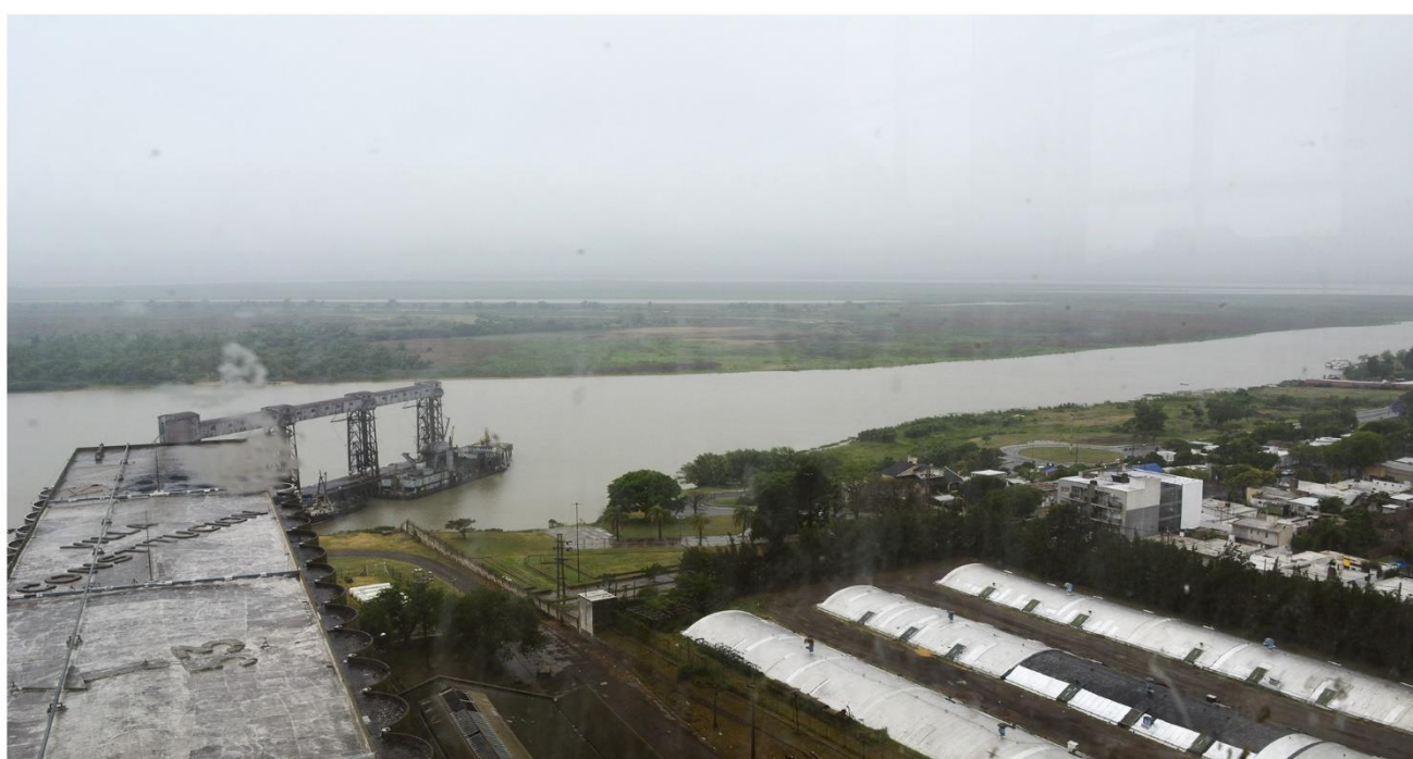
Vista playa de maniobras hacia Elevador Terminal, edificio ex Junta Nacional de Granos. Galpones e infraestructura varia Unidad
