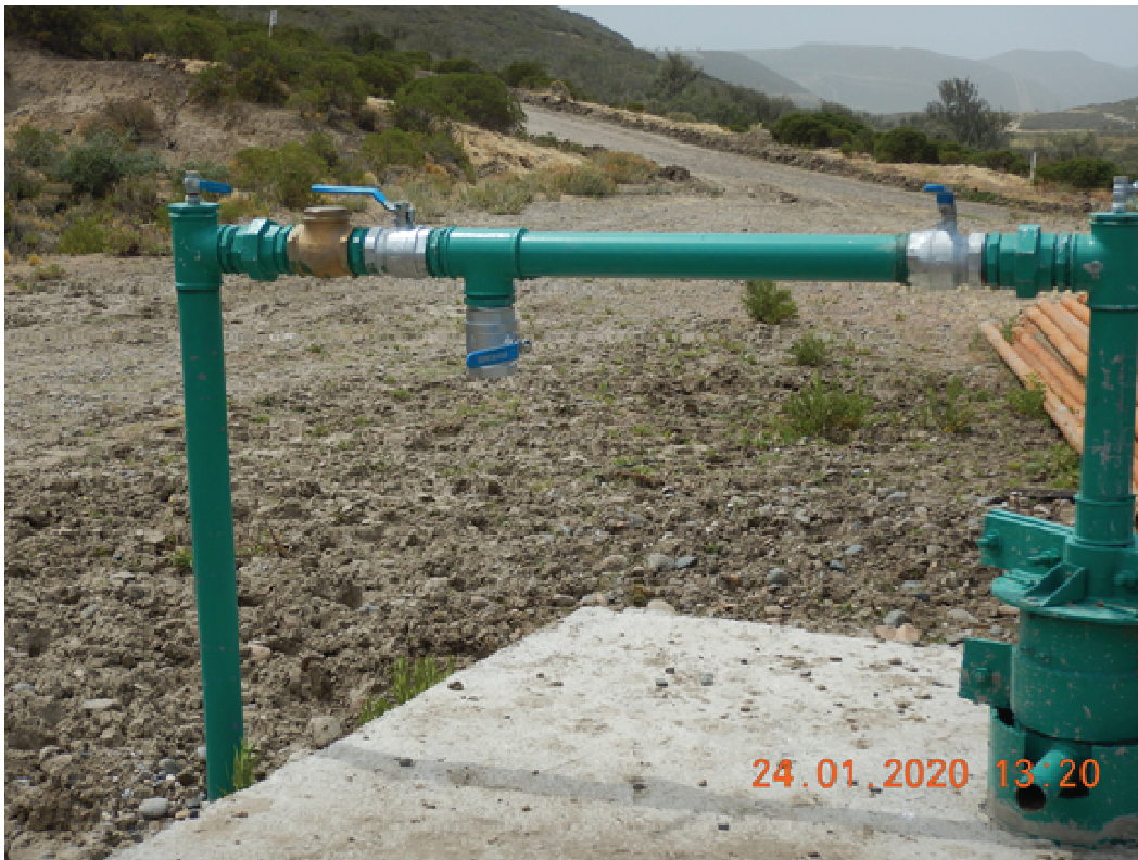
Imagen 5.19. Vista general pozo A
