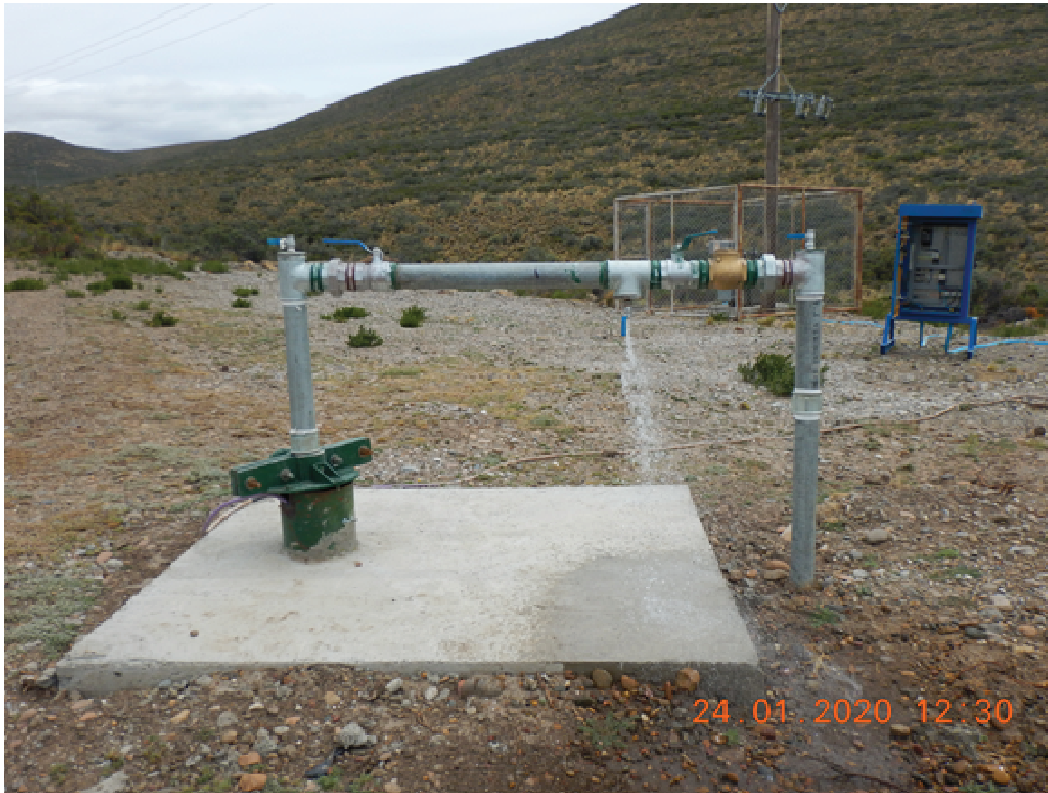
Imagen 5.20. Vista general pozo B
