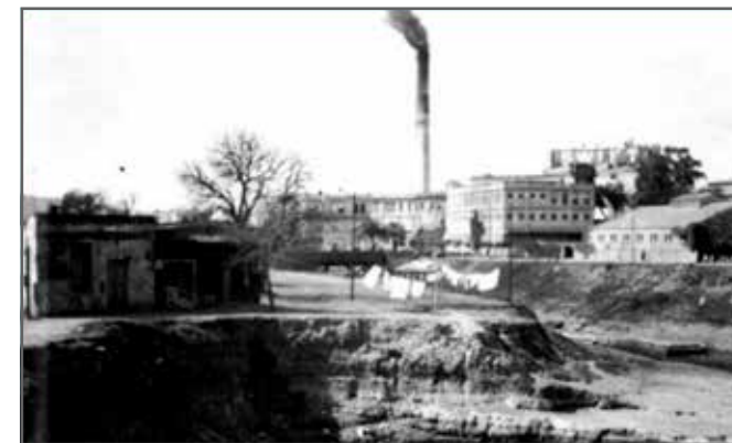
Decaída del Frigorífico Swift, asentamientos irregulares.
