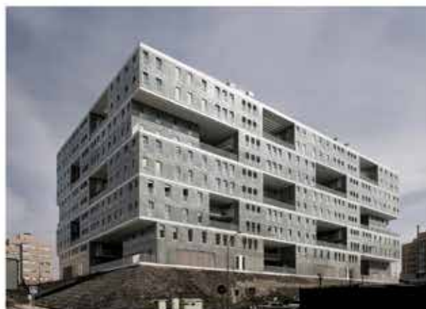
Celosía - MVRDV ARQUITECTOS. VIVIENDA COLECTIVA UBICACIÓN: MADRID, ESPAÑA.
